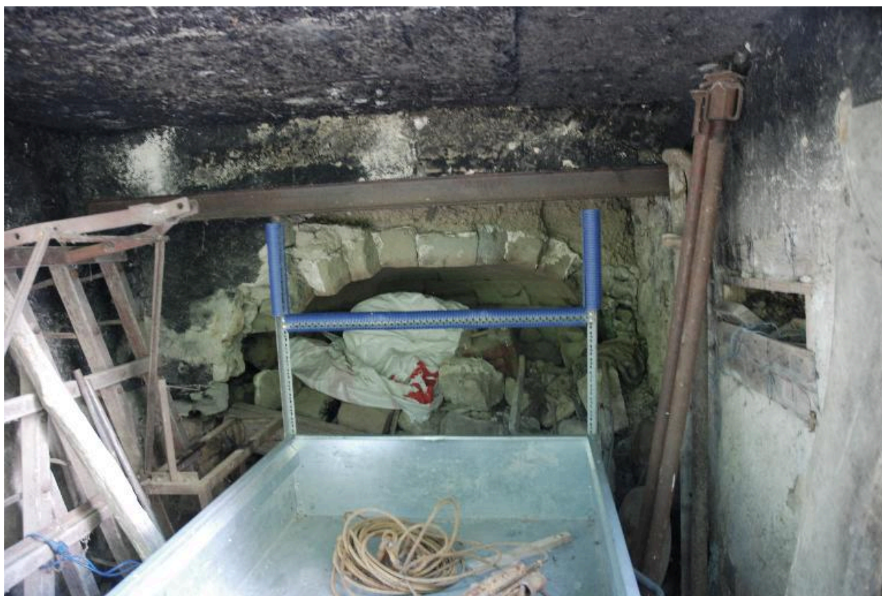
Vue partielle intérieure du four à pain.
