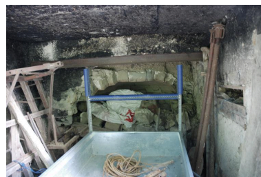
Vue partielle intérieure du four à pain. Phot. Thierry Monnet IVR82_20157302573NUCA
