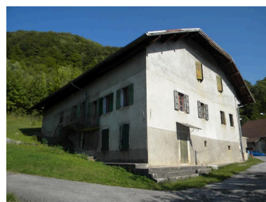
Vue d'ensemble d'une ancienne ferme au nord du hameau (2008 D14 2169). Phot. Jérôme Daviet IVR82_20137401150NUCA
