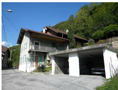
Vue d'une maison remaniée à l'entrée du hameau (2008 D14 2157). Phot. Jérôme Daviet IVR82_20137401143NUCA
