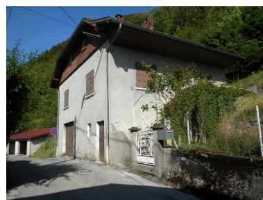
Vue d'une maison reprise au ciment avec tablettes moulurées sous les fenêtres (2008 D14 2159) Phot. Jérôme Daviet IVR82_20137401147NUCA
