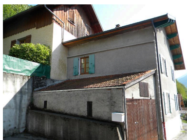
Façade nord d'une maison remaniée (2008 D14 2157). Phot. Jérôme Daviet IVR82_20137401145NUCA
