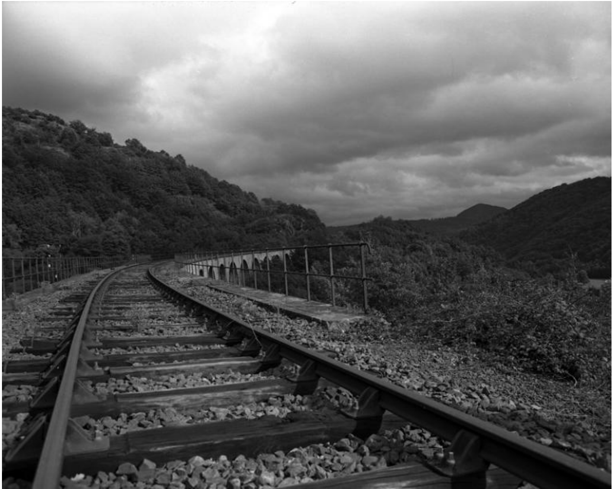
Vue de la voie ferrée à son passage sur le viaduc de Salsignac.
