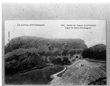
Vue du chantier de la ligne Bort-Neussargues aux abords du tunnel d'Antignac, au début du 20e siècle.
