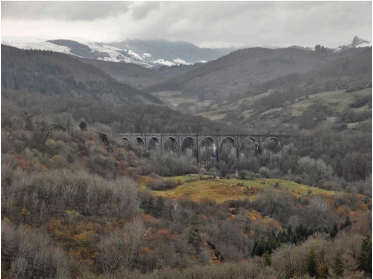
Le viaduc courbe de Barajol, entre Riom-ès-Montagne et Lugarde.
