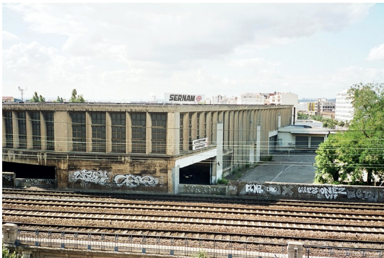
Vue générale nord
