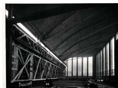
Détail charpente IVR82_20056900192NUCB
