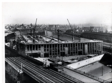
Construction du hangar SNCF, état en mars 1948 (archives SNCF) IVR82_20056900185NUCB
