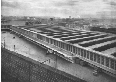
Vue de la gare de la Guillotière et des entrepôts de la Sernam (Fond Tabey AC Lyon) Phot. Nadine Halitim-Dubois IVR84_20176900361NUC
