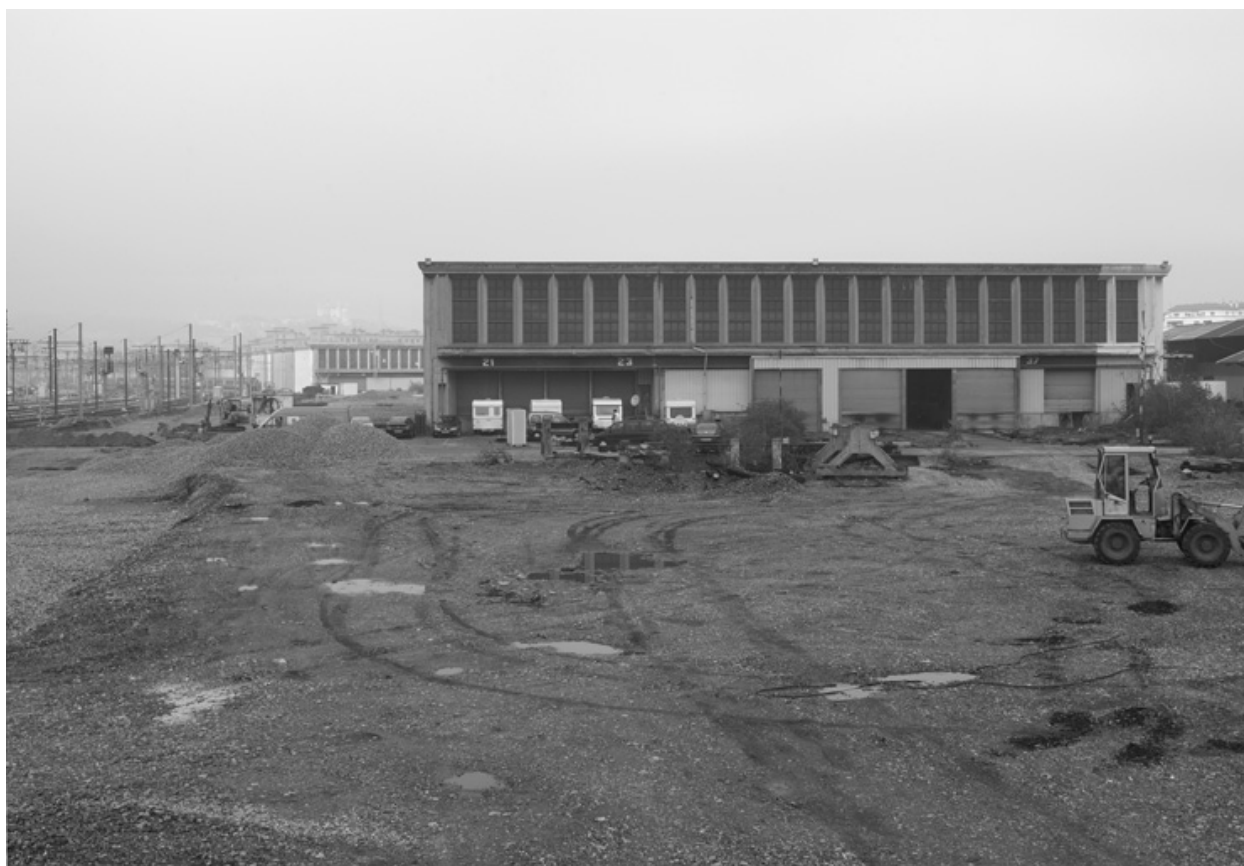
Partie est du site
