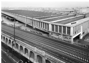
Vue nord des ateliers Phot. Didier Gourbin IVR82_20046902658P
