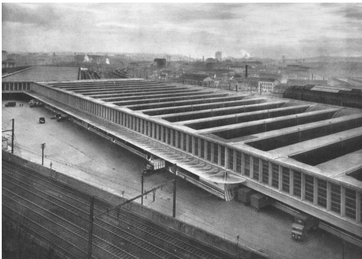
Vue de la gare de la Guillotière et des entrepôts de la Sernam (Fond Tabey AC Lyon)
