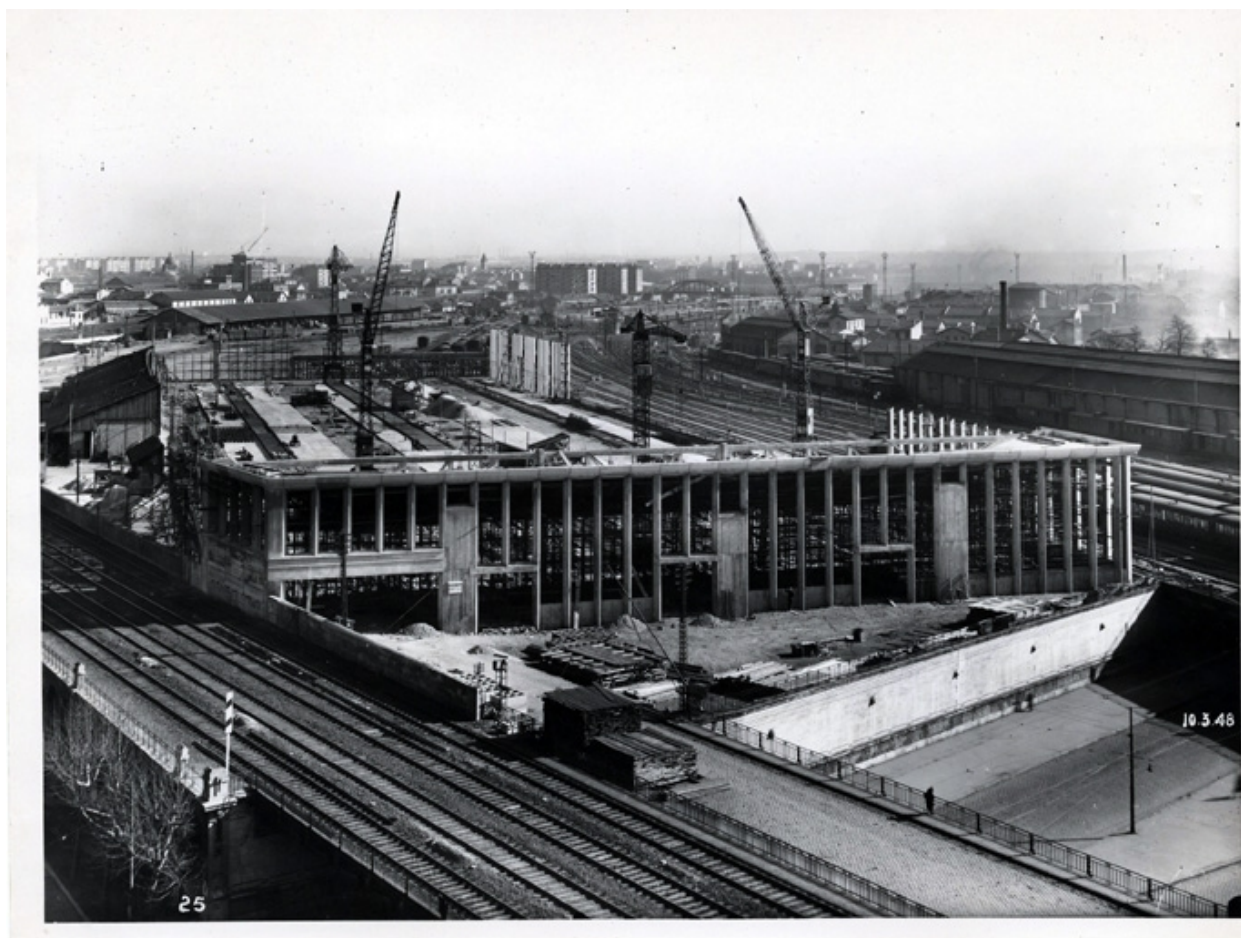
Construction du hangar SNCF, état en mars 1948 (archives SNCF)
