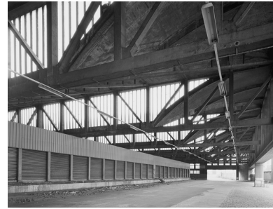
Charpente : shed structure béton Phot. Didier Gourbin IVR82_20076900829V
