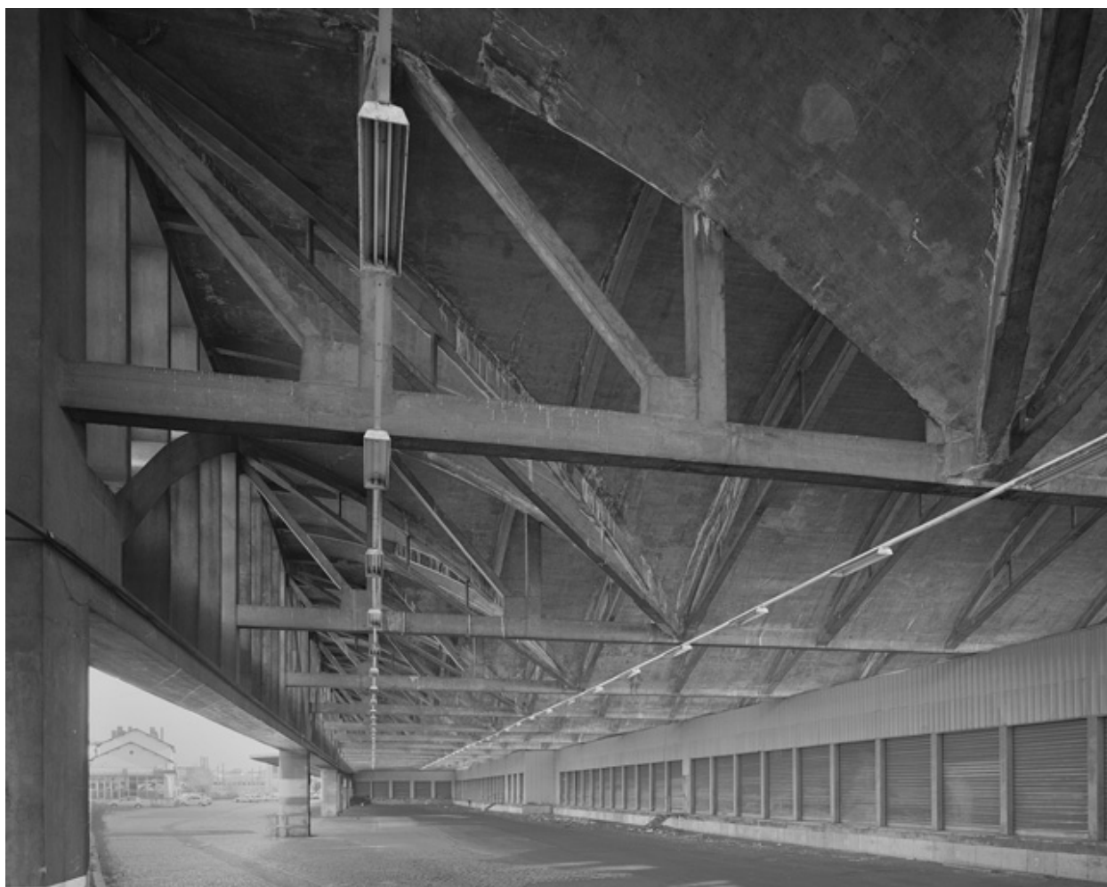
Charpente béton
