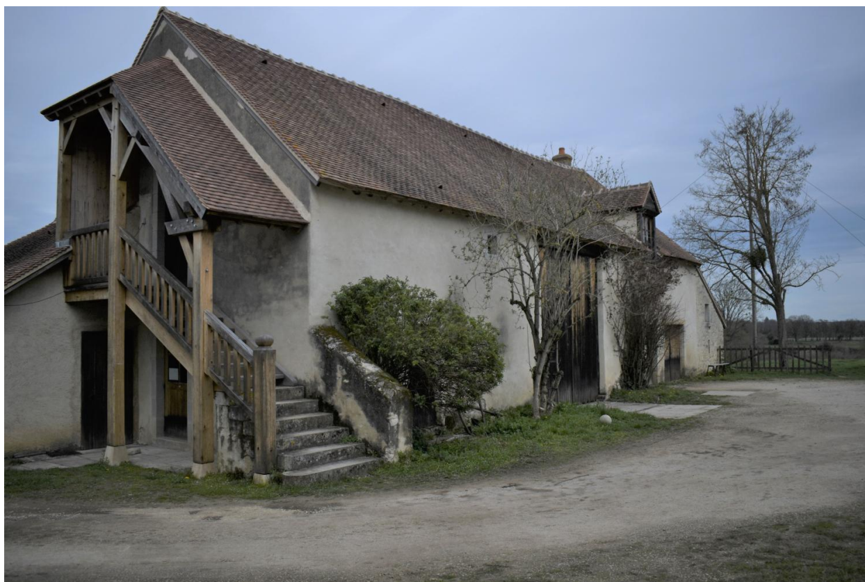
Vue de la grange vers l'est.
