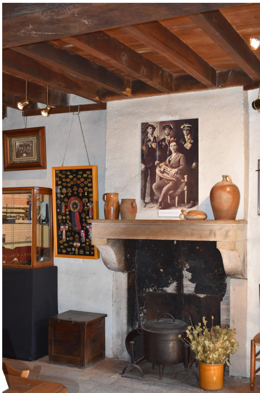
Logis : détail de la cheminée (pièce nord) et détail du plafond à solives apparentes.
