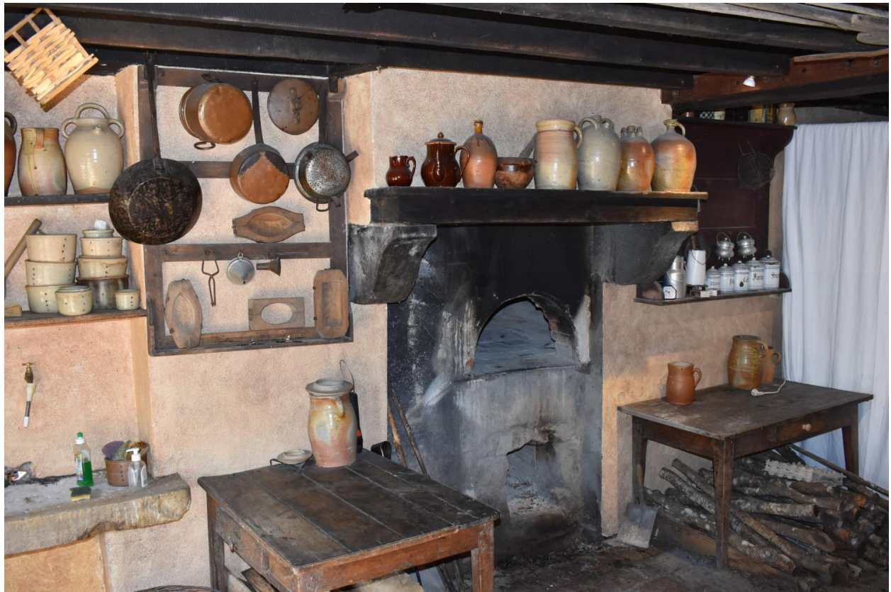
Logis : cheminée avec ouverture du four donnant sur la pièce de la bassie.
