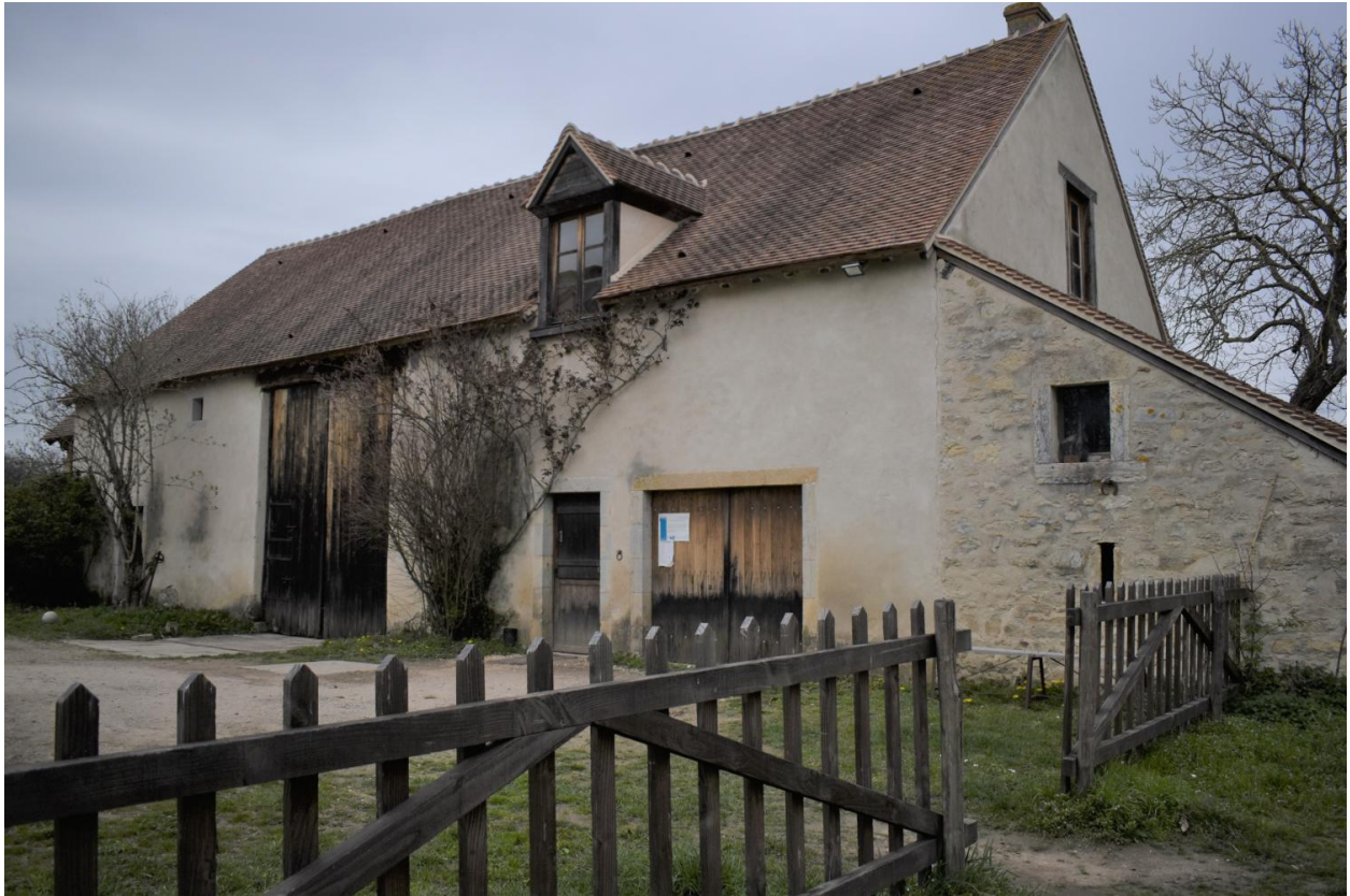
Vue générale de la grange.
