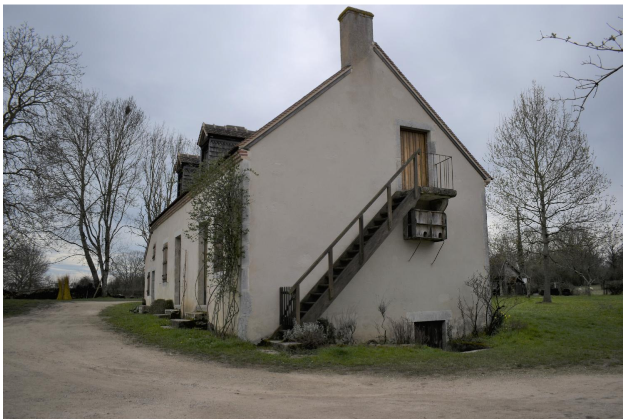
Logis : vue du mur pignon nord.
