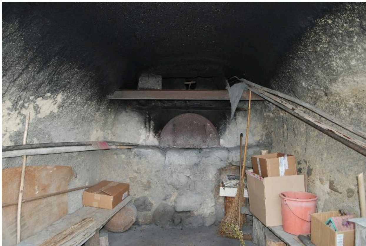
Vue d'ensemble intérieure du four à pain.
