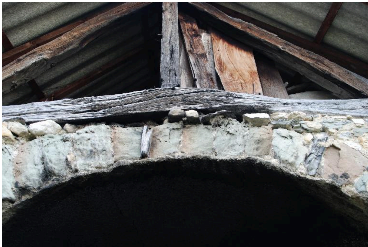
Détail de la voûte de l'espace avant du four à pain.
