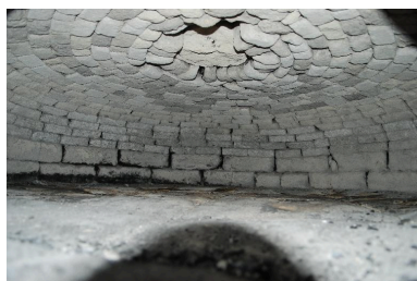
Vue partielle de la voûte du four à pain. Phot. Thierry Monnet IVR84_20177301956NUCA
