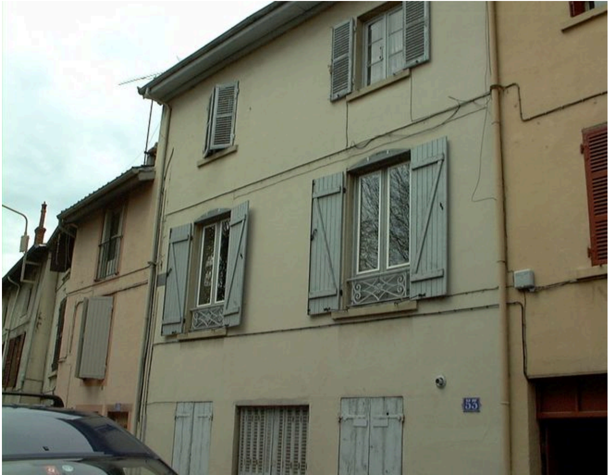
Détail de l'élévation antérieure
