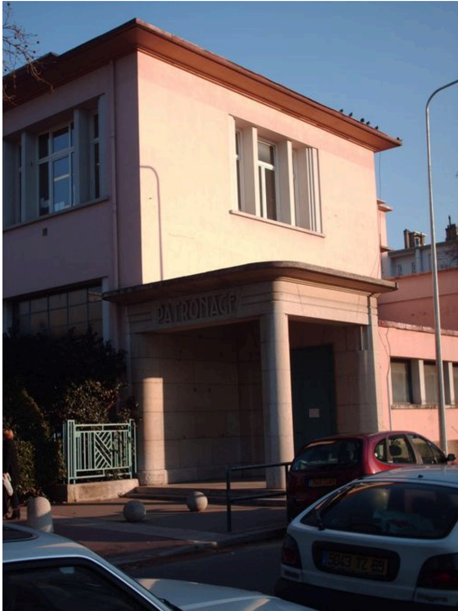
Vue partielle de l'angle nord-ouest depuis la place Camille-Flammarion vers le patronage
