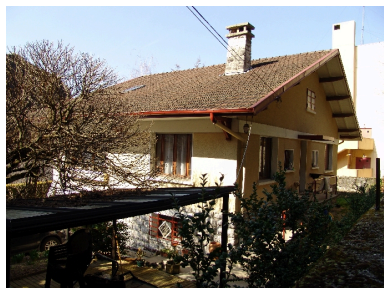
Vue d'ensemble prise du sud-est Phot. François Fouger IVR82_20097300580NUCA
