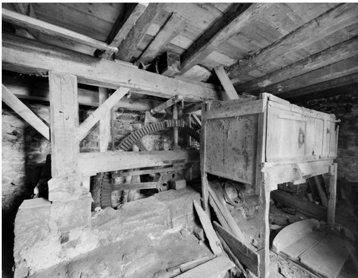
Rez-de-chaussée surélevé, vue d'ensemble du blutoir.
