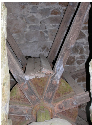
Façade ouest du moulin, détail axe de la roue à aubes. Phot. Thierry Monnet IVR82_20124200015NUCA
