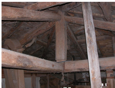
Rez-de-chaussée surélevé, vue sur la charpente. Phot. Thierry Monnet IVR82_20124200034NUCA
