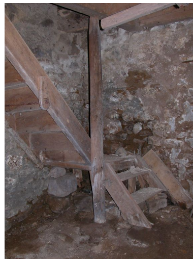
Étage de soubassement, escalier d'accès au rez-de-chaussée surélevé. Phot. Thierry Monnet IVR82_20124200023NUCA
