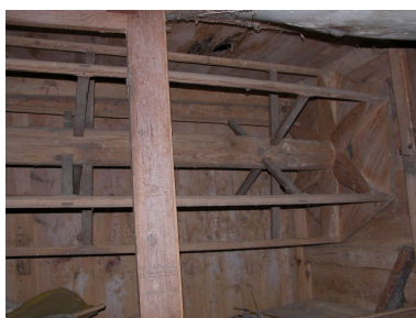
Rez-de-chaussée surélevé, blutoir, vue intérieure. Phot. Thierry Monnet IVR82_20124200032NUCA
