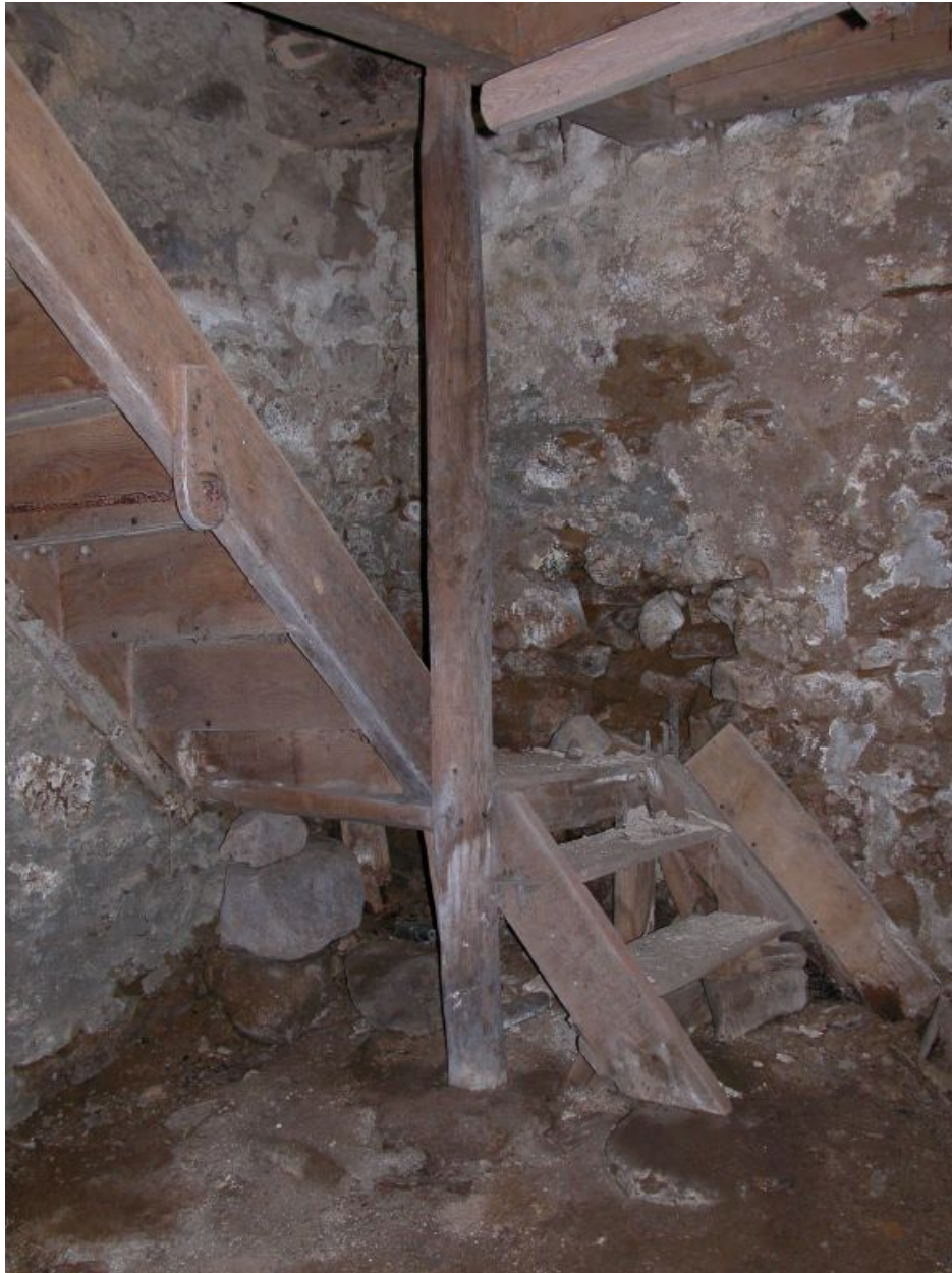
Etage de soubassement, escalier d'accès au rez-de-chaussée surélevé.
