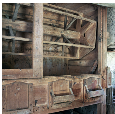
Rez-de-chaussée surélevé, vus partielle du blutoir. Phot. Didier Gourbin IVR82_20064200830NUCA
