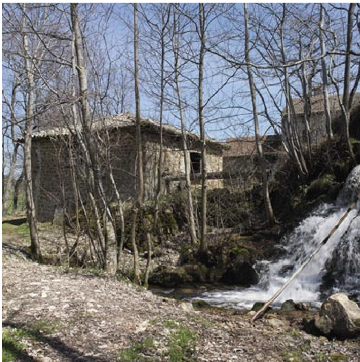
Vue d'ensemble du moulin de trois-quarts sud-ouest
