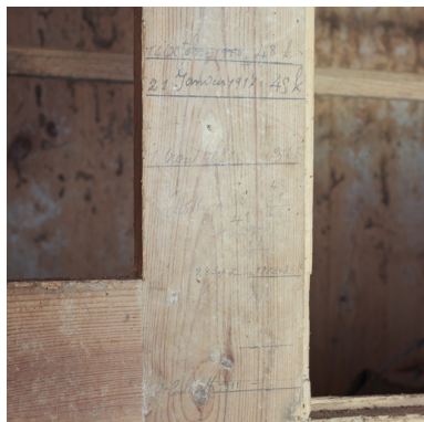
Rez-de-chaussée surélevé, blutoir, inscription : quantités. Phot. Didier Gourbin IVR82_20064200831NUCA
