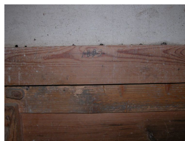
Rez-de-chaussée surélevé, blutoir, date. Phot. Thierry Monnet IVR82_20124200033NUCA
