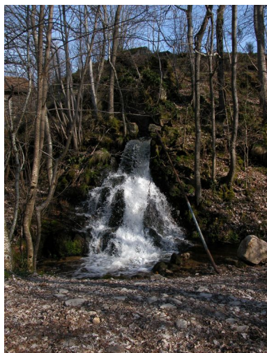
Trop-plein du bief se jetant dans la rivière en amont du moulin. Phot. Thierry Monnet IVR82_20124200039NUCA
