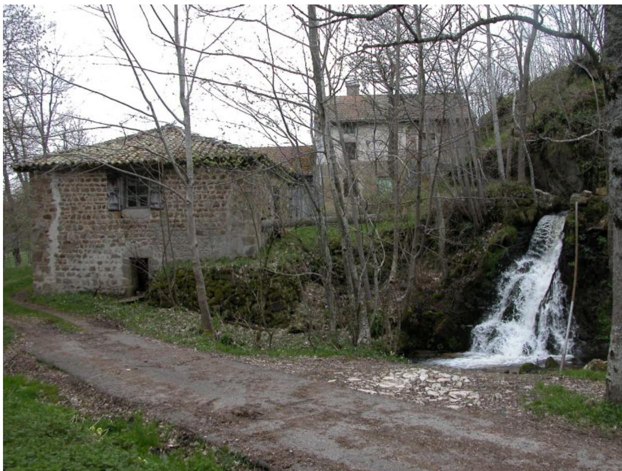
Vue d'ensemble du moulin de trois-quarts sud-ouest.
