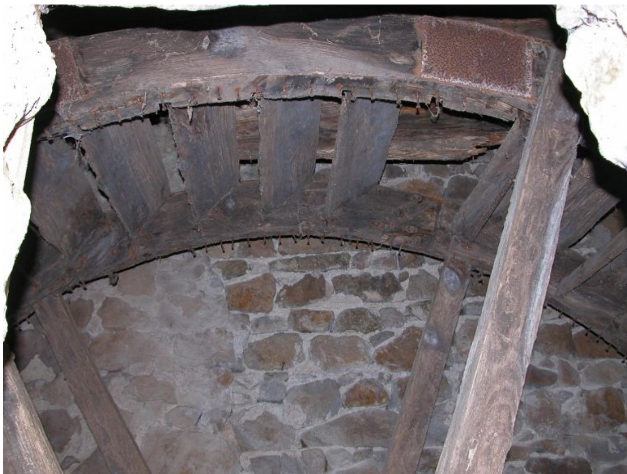
Façade ouest du moulin, détail roue à aubes.
