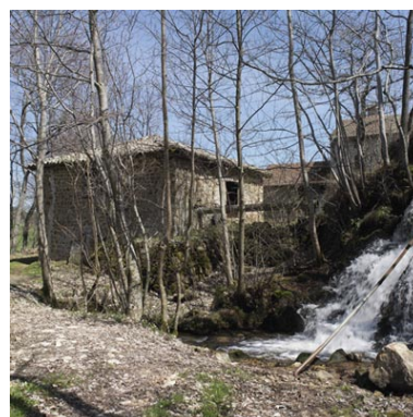
Vue d'ensemble du moulin de trois-quarts sud-ouest Phot. Didier Gourbin IVR82_20064200827NUCA
