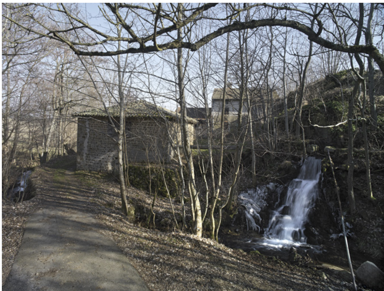
Vue générale du moulin dans son site.
