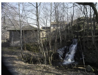
Vue générale Phot. Eric Dessert IVR82_20084200164NUCA
