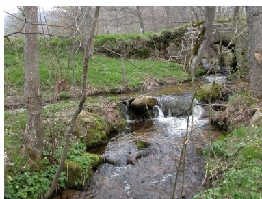
Départ du bief depuis la rivière de la Trésaillette. Phot. Thierry Monnet IVR82_20124200036NUCA
