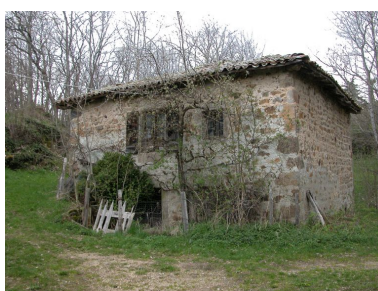
Vue d'ensemble rapprochée du moulin de trois-quarts nord-est. Phot. Thierry Monnet IVR82_20124200010NUCA
