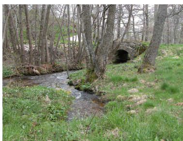
Bief se dirigeant vers le moulin. Phot. Thierry Monnet IVR82_20124200037NUCA
