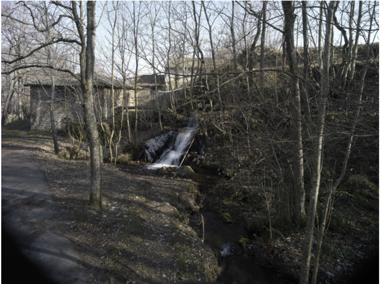
Vue générale du moulin dans son site.
