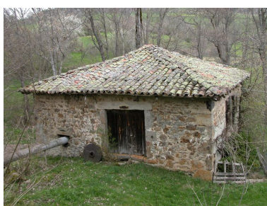
Vue d'ensemble du moulin depuis le sud-est. Phot. Thierry Monnet IVR82_20124200012NUCA
