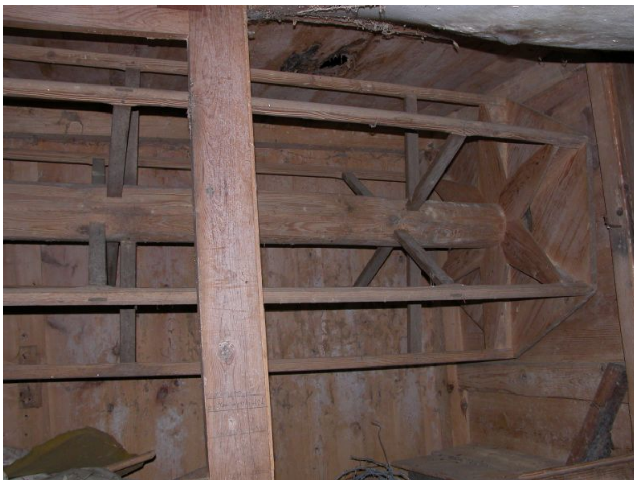
Rez-de-chaussée surélevé, blutoir, vue intérieure.
