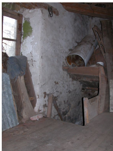
Rez-de-chaussée surélevé, débouché de l'escalier. Phot. Thierry Monnet IVR82_20124200024NUCA
