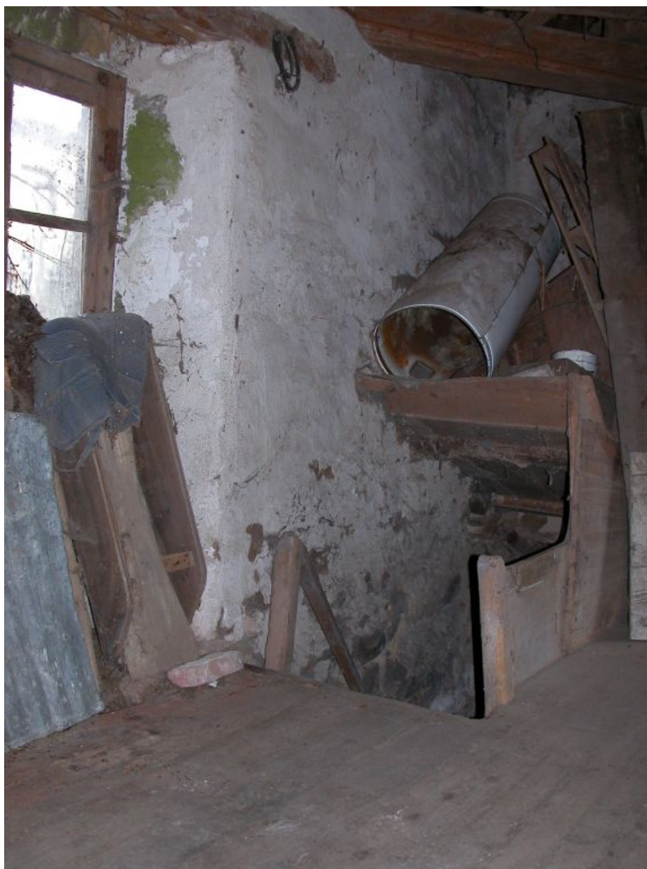
Rez-de-chaussée surélevé, débouché de l'escalier.
