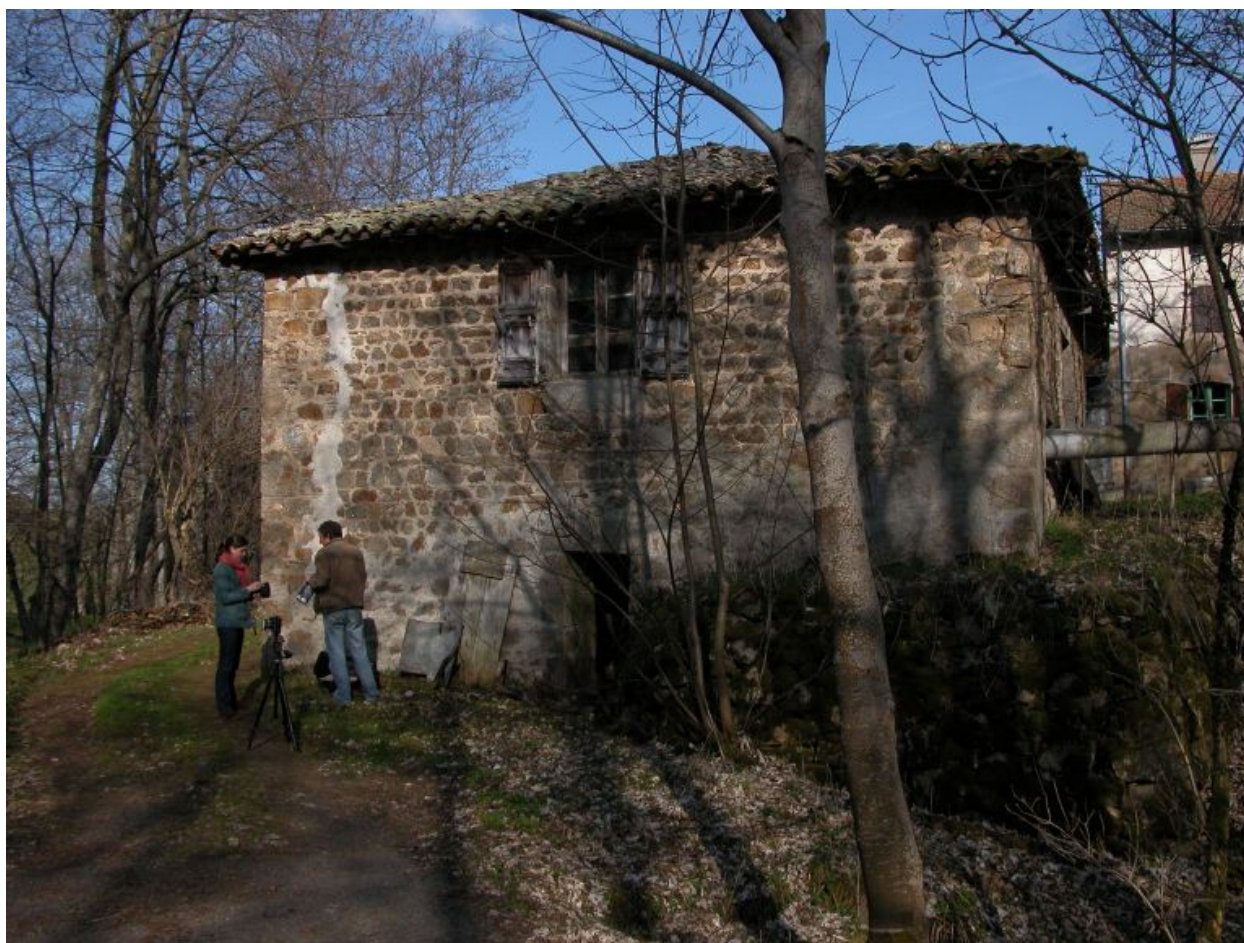
Vue d'ensemble du moulin depuis l'ouest.
