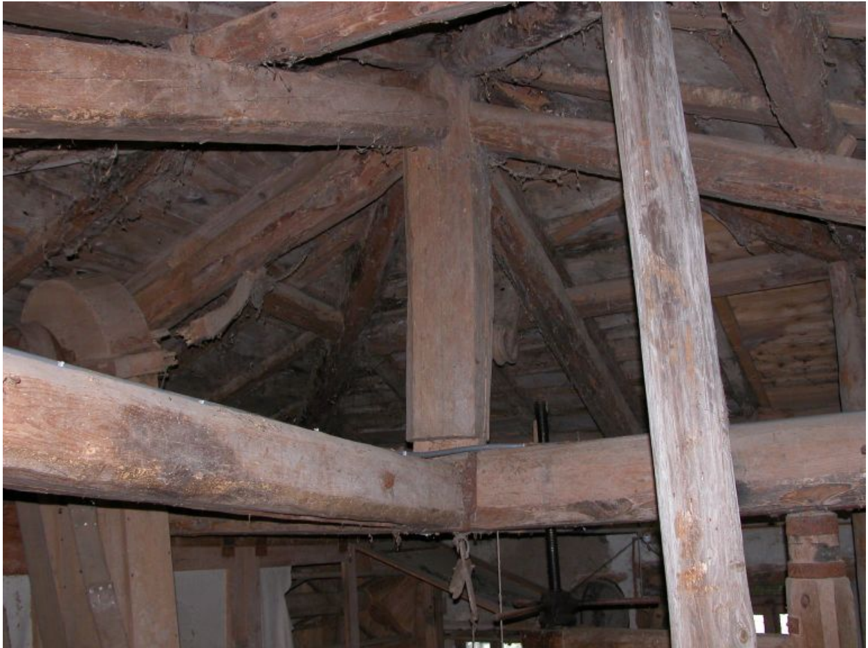
Rez-de-chaussée surélevé, vue sur la charpente.
