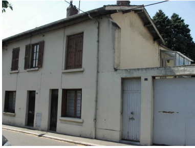
façade sud est Phot. Benoît Chapelle IVR82_20073800058NUCA
