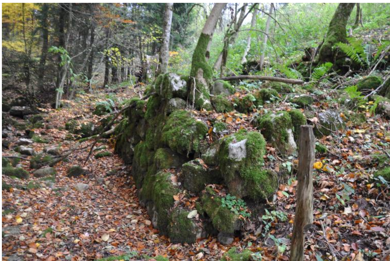
Murs indiquant les vestiges de la prise d'eau
