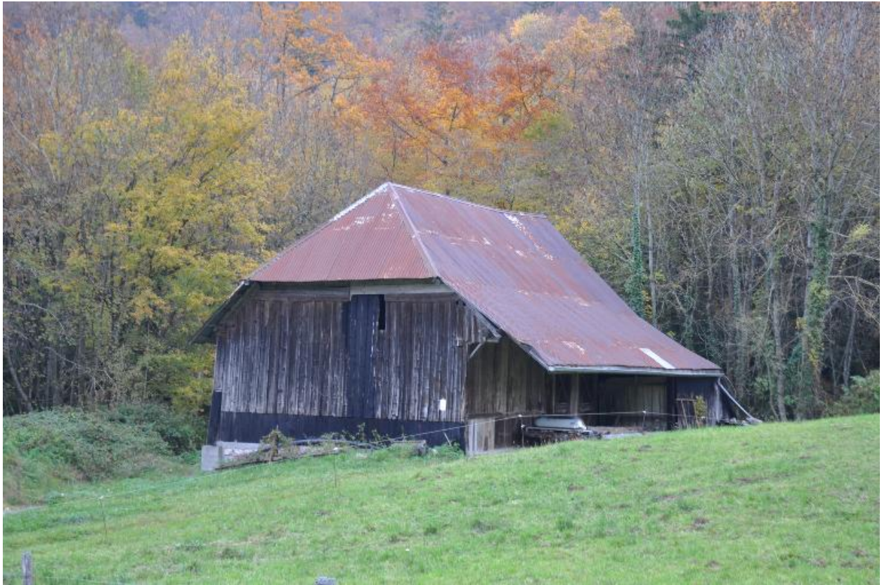
Le toit en tôle ondulée se signale dans ce champs situé à proximité de la route d'Entrevernes
