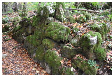
Détail des vestiges de la prise d'eau Phot. Samir Mahfoudi IVR82_20177400102NUCA
