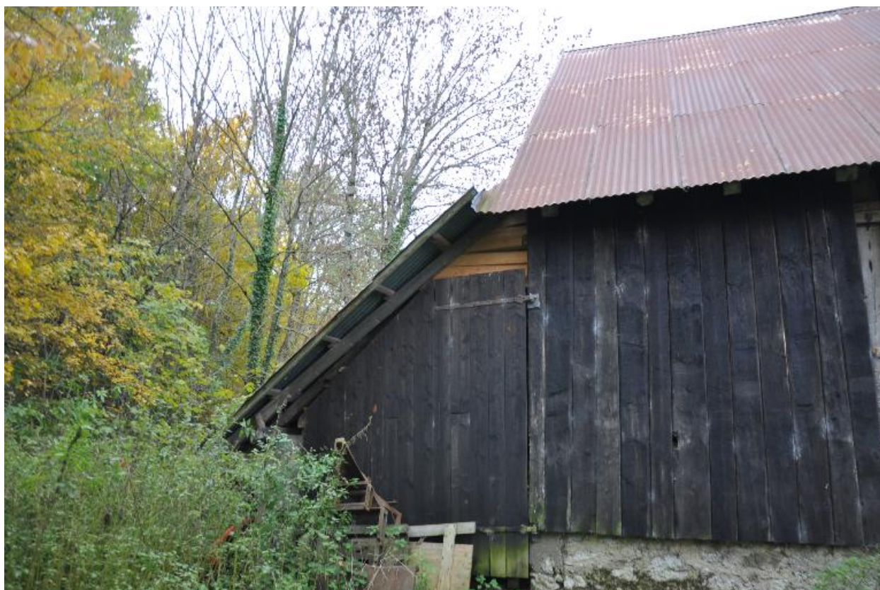
Détail de l'extension en appentis se trouvant au sud-ouest qui est en fait le bâtiment originel de la scierie
