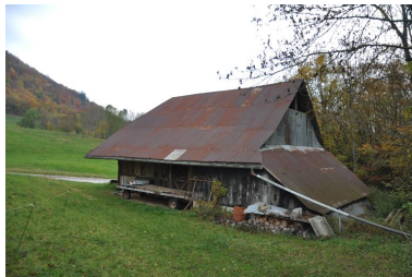
L'extension en appentis semi- enterrée correspond en partie à l'ancien bâtiment de la scierie Phot. Samir Mahfoudi IVR82_20177400106NUCA
