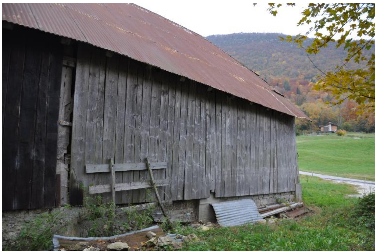
Détail de la façade latérale nord
