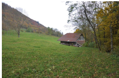
Vue d'ensemble de la remise prise à la lisière du bois du Marquis de Sales Phot. Samir Mahfoudi IVR82_20177400105NUCA
