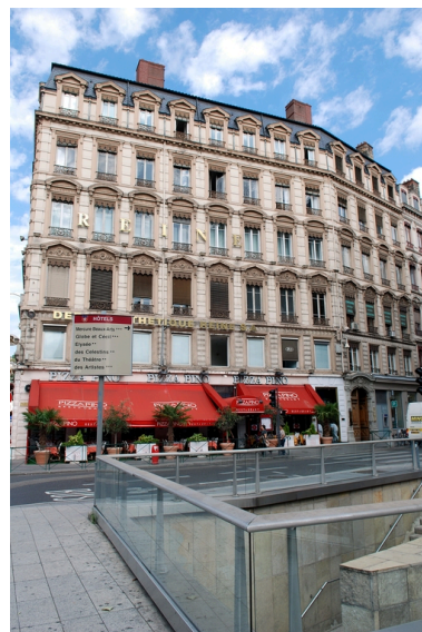
Elévations place Le Viste et rue du Président-Edouard-Herriot Phot. Véronique Belle IVR82_20096904977NUCA
