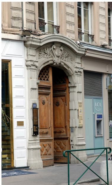
Elévation rue du Président- Edouard-Herriot : la porte Phot. Véronique Belle IVR82_20096904978NUCA
