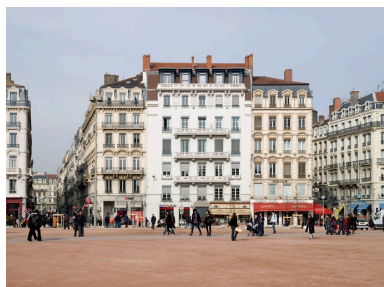
Vue de situation, en 2009 Phot. Bertrand Stofleth IVR82_20096902360NUCA
