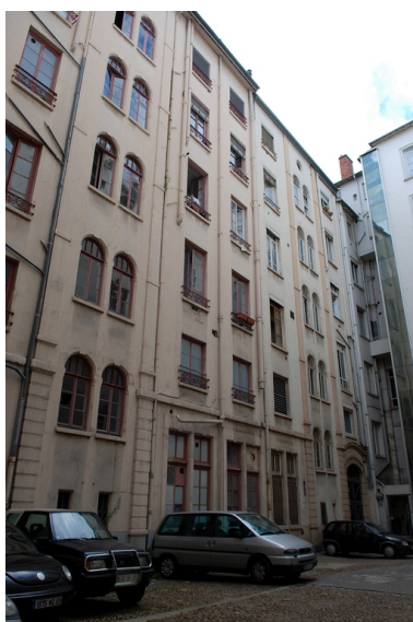
Elévation sur cour Phot. Véronique Belle IVR82_20096904980NUCA
