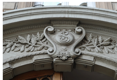
Elévation rue du Président- Edouard-Herriot : la porte, détail du fronton cintré Phot. Véronique Belle IVR82_20096904979NUCA
