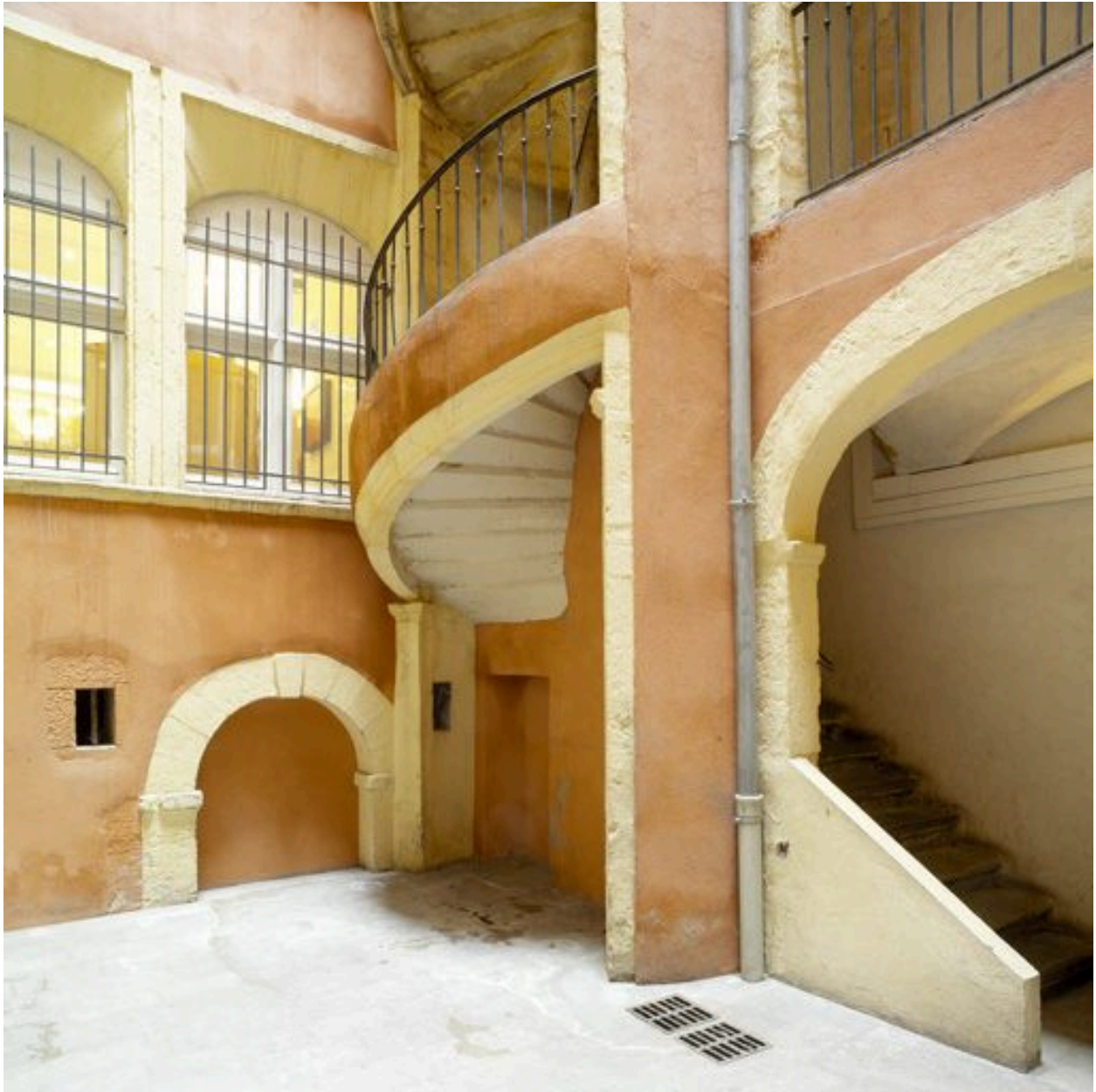
Angle sud-est de la cour, rez-de-chaussée
