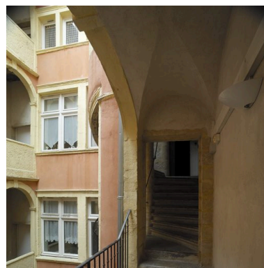
Cage d'escalier et élévation est de la cour depuis la galerie sud, 4e étage Phot. Didier Gourbin IVR82_20056901803NUCA
