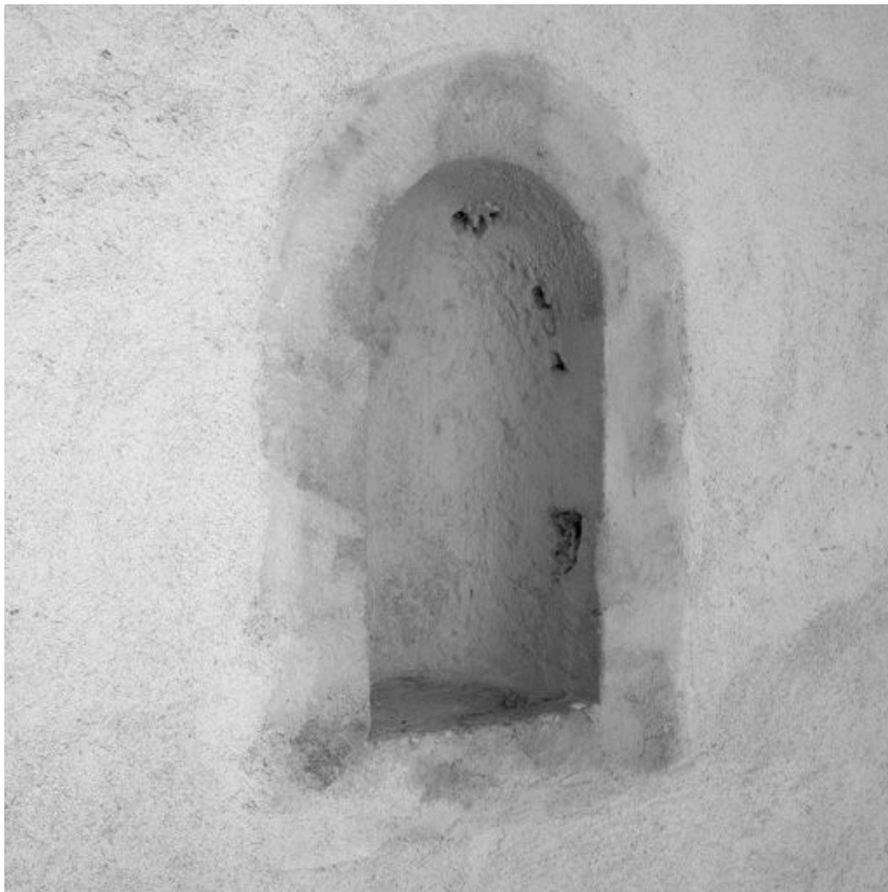
Niche d'éclairage de l'escalier
