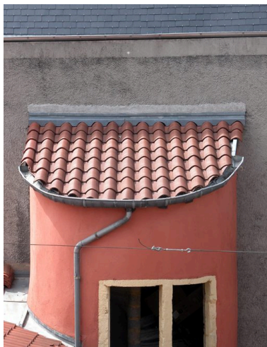
L'étage de guette depuis l'escalier du 42 rue Mercière Phot. Alexandre Rémond IVR82_20046905046NUCA
