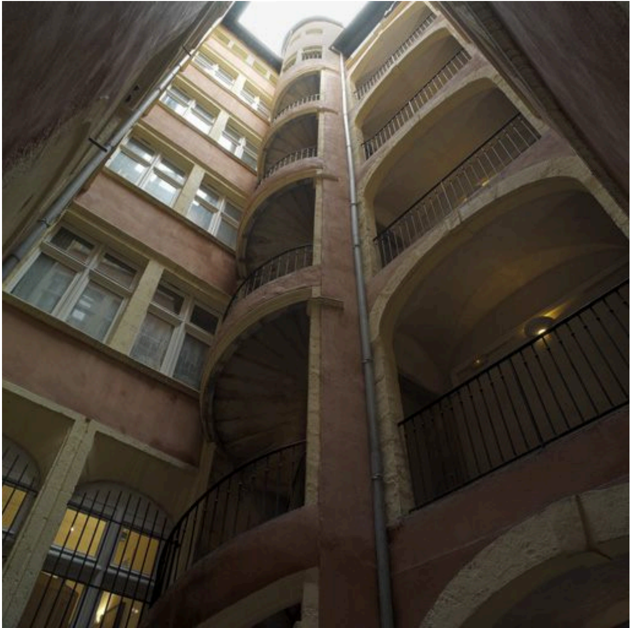
Elévations est et sud de la cour avec la cage d'escalier au centre depuis le rez-de-chaussée
