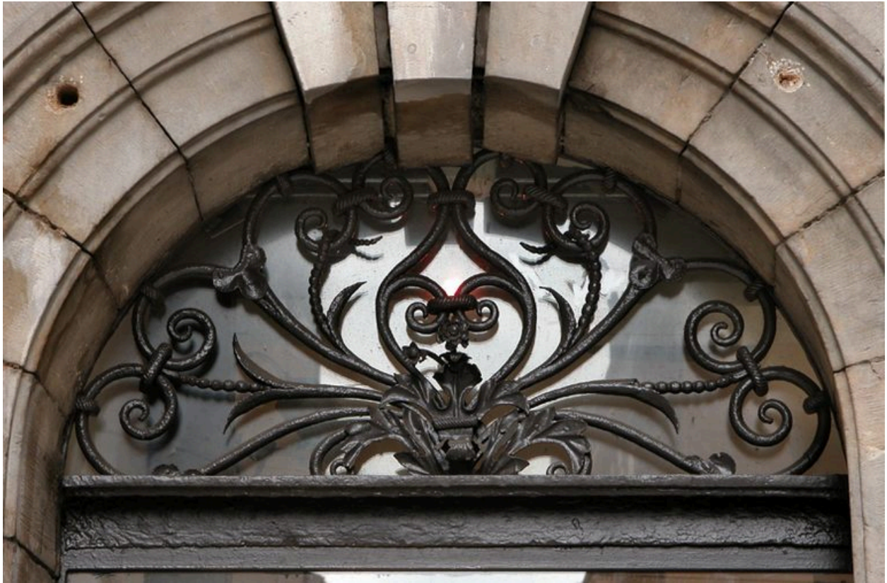
Rue Mercière : détail du tympan de ferronnerie
