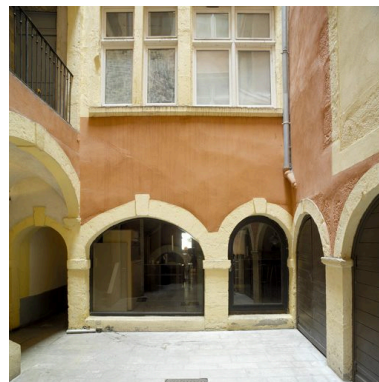
Elévations sud, ouest et nord de la cour, rez-de-chaussée Phot. Didier Gourbin IVR82_20056901809NUCA
