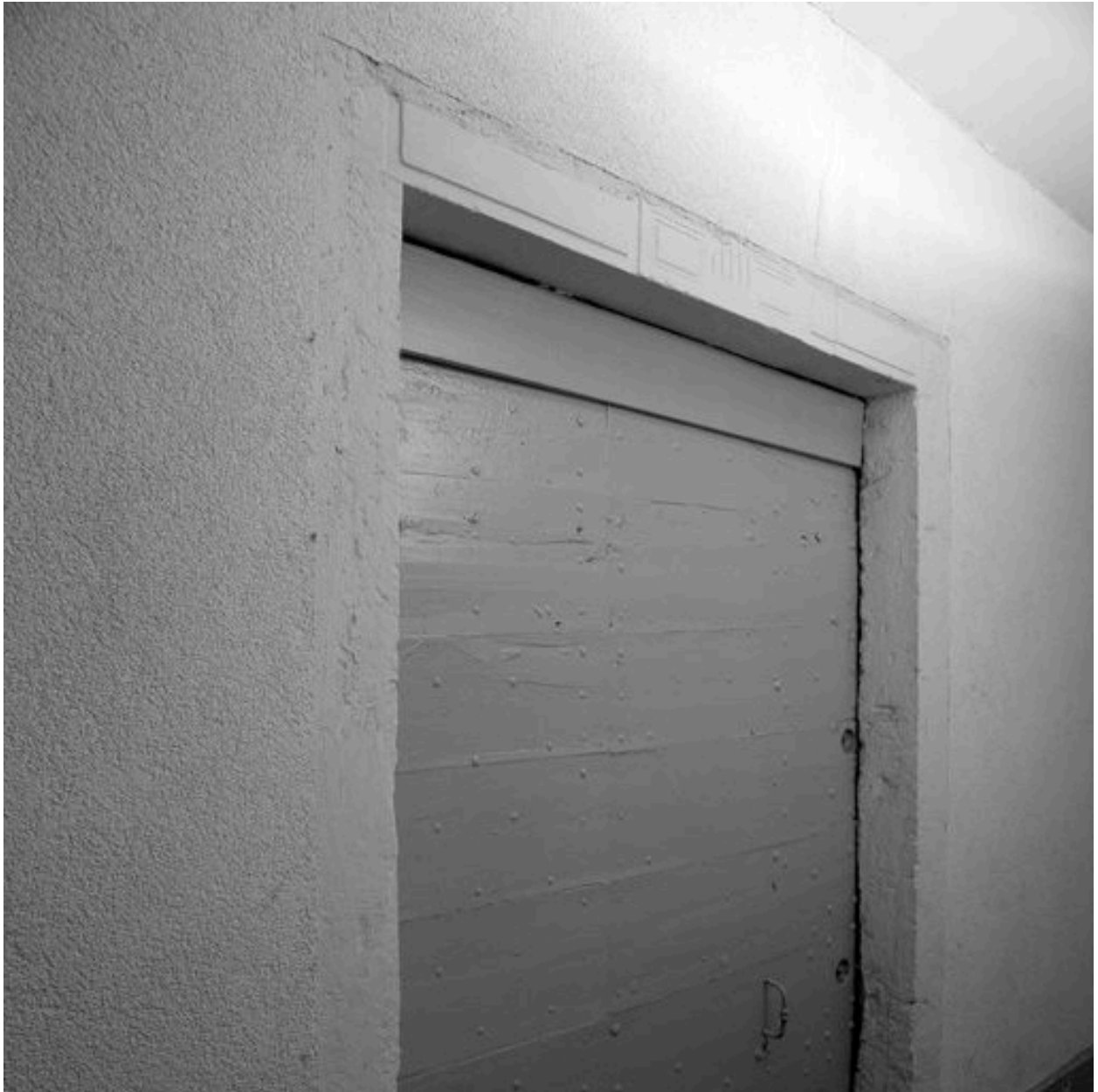
Détail du linteau de porte situé dans l'allée, à gauche en entrant
