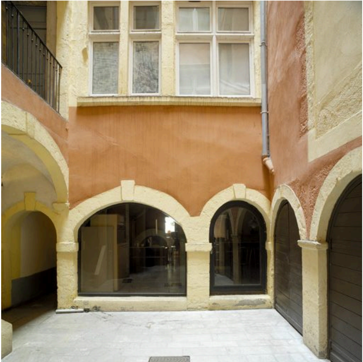
Elévations sud, ouest et nord de la cour, rez-de-chaussée
