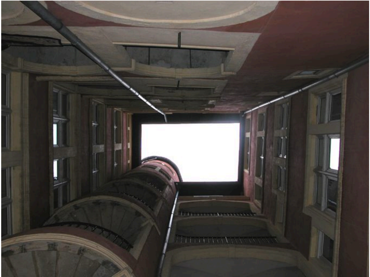
Vue de la cour en contre-plongée
