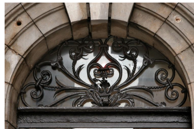
Rue Mercière : détail du tympan de ferronnerie Phot. Alexandre Rémond IVR82_20046905045NUCA
