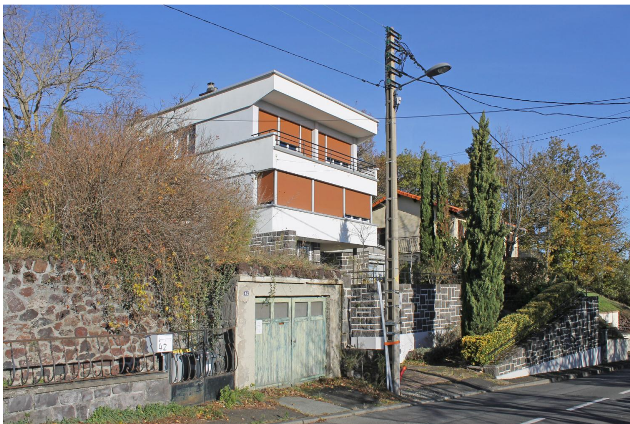
Durtol, la maison I. vue depuis le sud.
