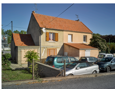
Maison double de la cité des "Sports", boulevard Étienne-Clémentel. Phot. Christian Parisey IVR84_20196300354NUC4A
