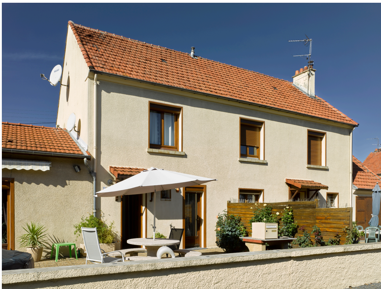
Habitation double de la petite unité de logements ouvriers des "Sports", boulevard Étienne-Clémentel.
