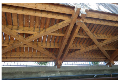
Pont du Nant de la Ville, vue du dessous de la passerelle piétonne aval Phot. Pascale Renard IVR84_20207401213NUCA
