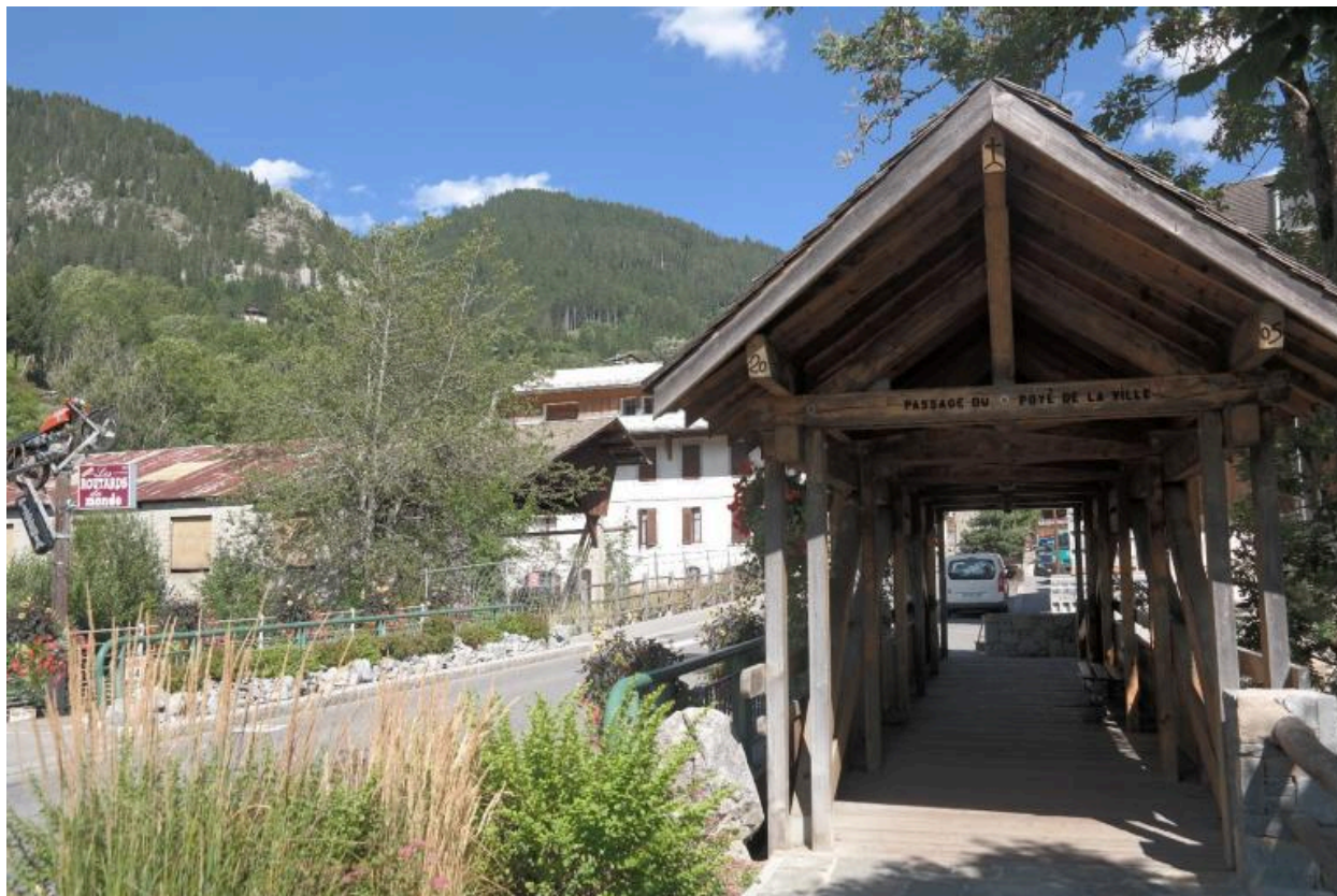
Pont du Nant de la Ville, vue de la passerelle piétonne couverte aval
