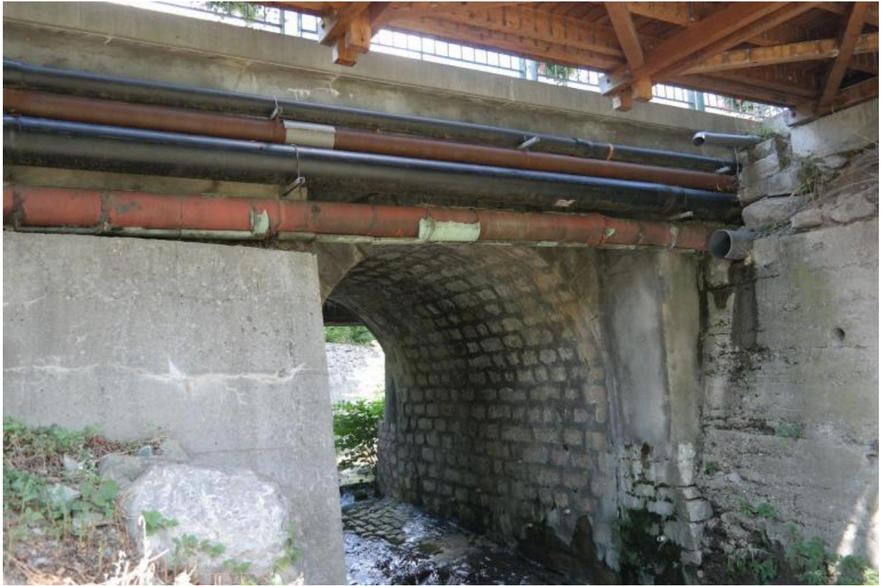
Pont du Nant de la Ville, vue du dessous
