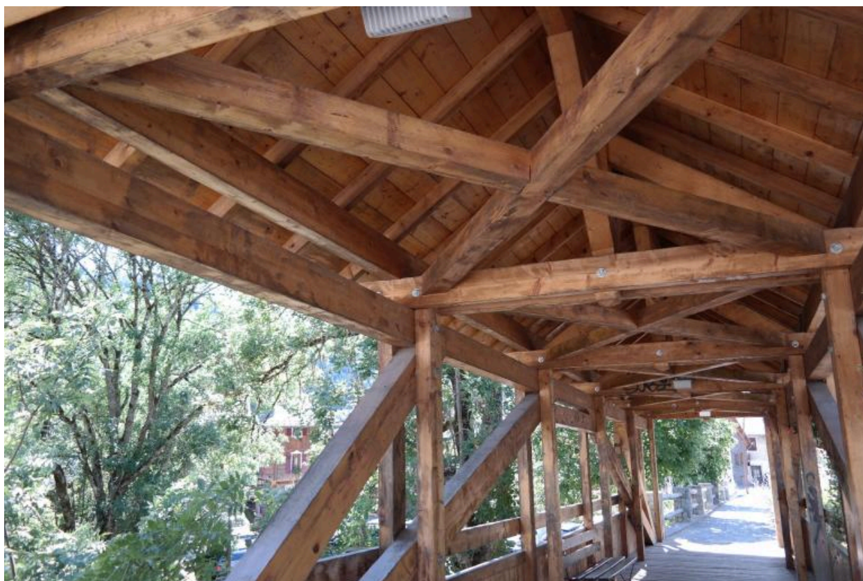
Pont du Nant de la Ville, vue de l'intérieur de la passerelle piétonne couverte aval
