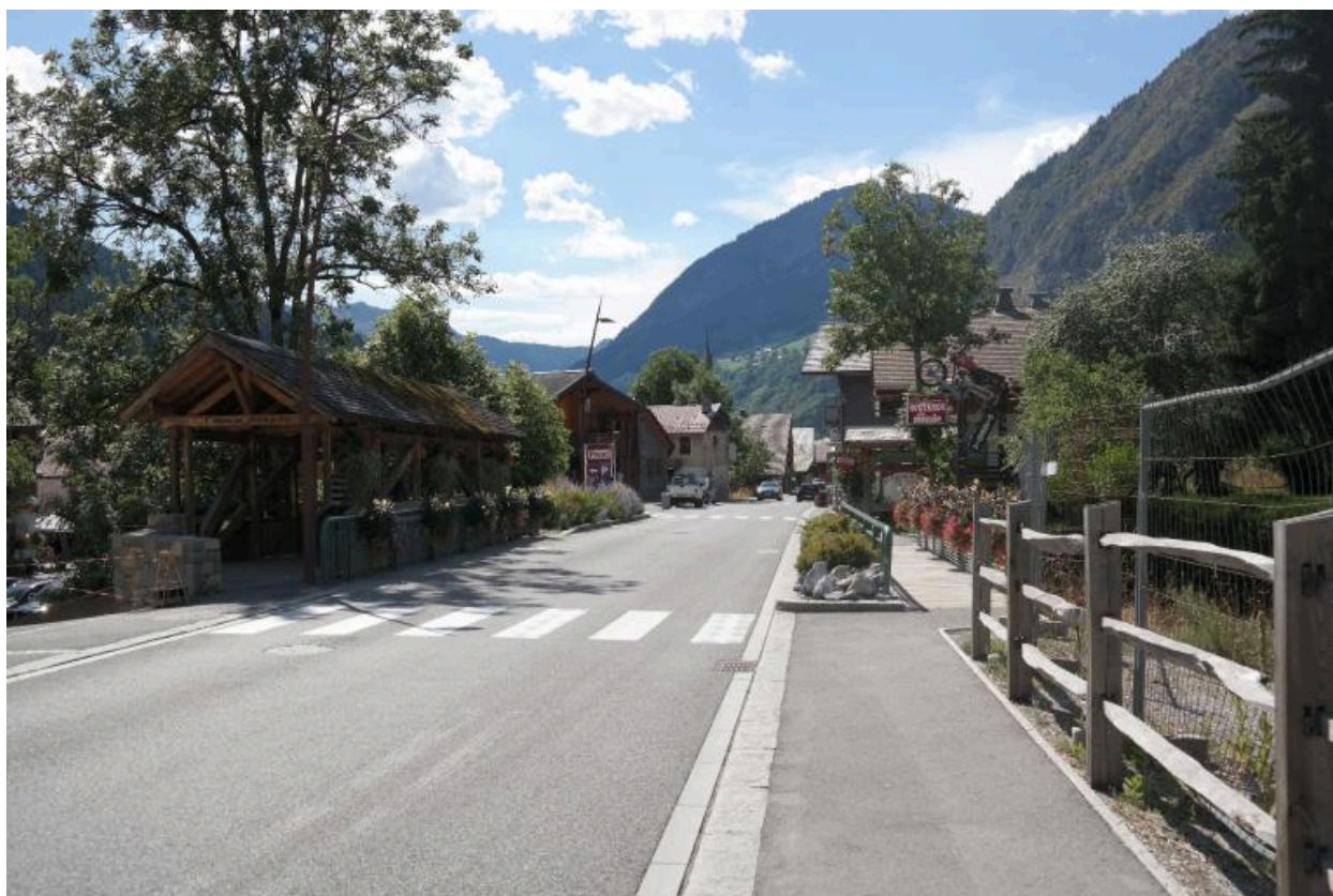
Pont du Nant de la Ville, vue de la chaussée et des passerelles
