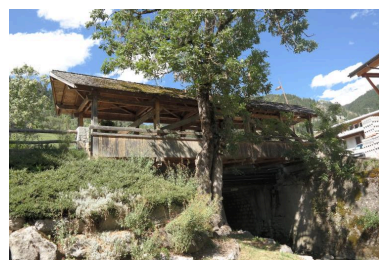
Pont du Nant de la Ville, vue de la face aval Phot. Pascale Renard IVR84_20207401208NUCA
