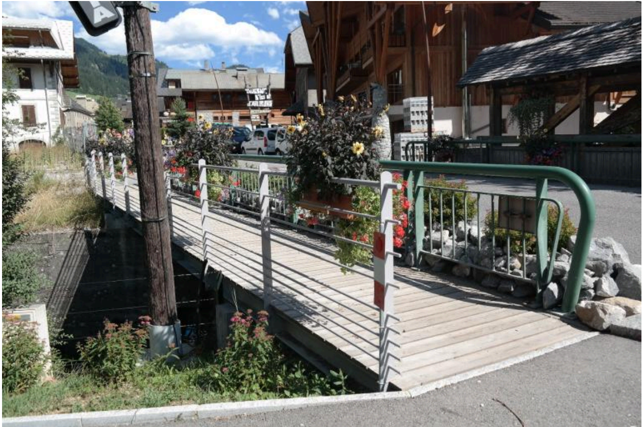
Pont du Nant de la ville, vue de la passerelle piétonne amont
