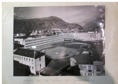
Vue d'ensemble du lycée en 1963.
