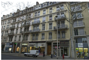
Vue d'ensemble des 15-17 avenue Jean-Jaurès Phot. Maryannick Chalabi IVR82_20046904379NUCA
