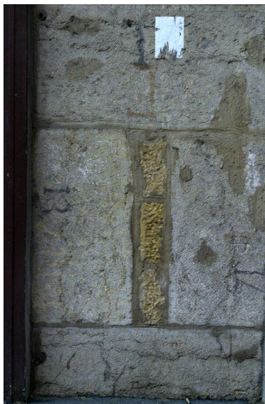
Détail des pierres de façade Phot. Maryannick Chalabi IVR82_20096901133NUCA
