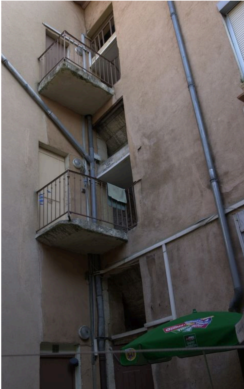
Les balcons sur cour distribuant le corps de bâtiment rue Creuzet
