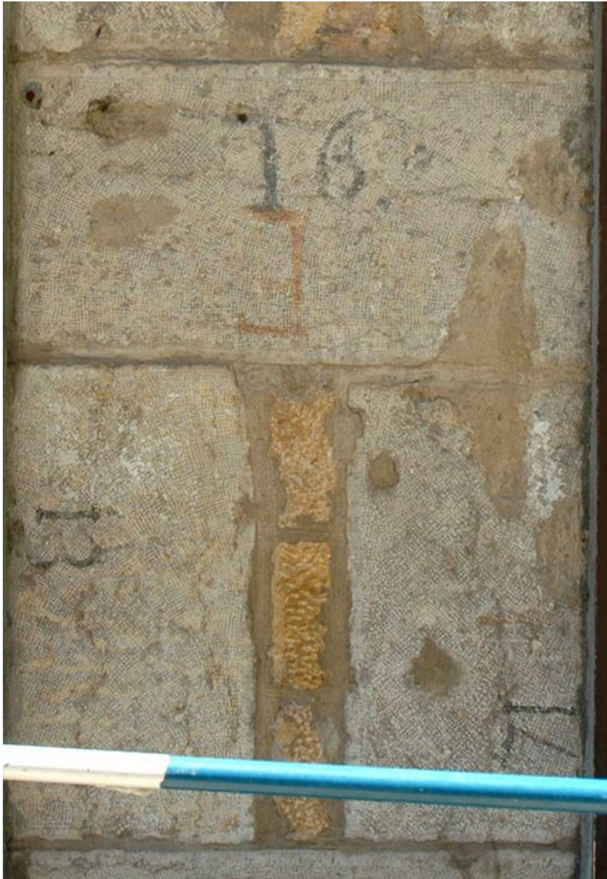
Détail des matériaux de façade, avec marques de pose
