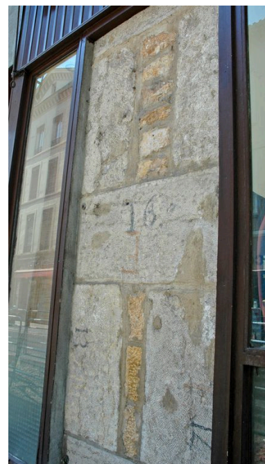
Détail des matériaux de façade, avec marques de pose Phot. Maryannick Chalabi IVR82_20066903077NUCA
