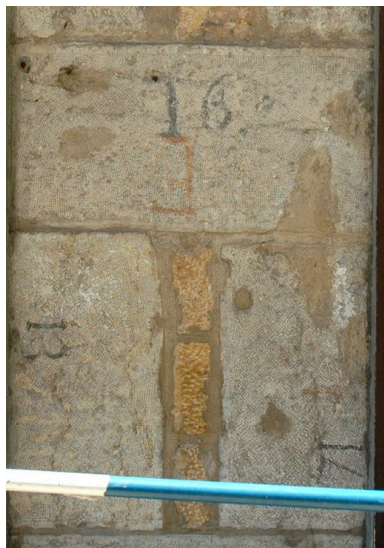
Détail des matériaux de façade, avec marques de pose Phot. Maryannick Chalabi IVR82_20066903078NUCA
