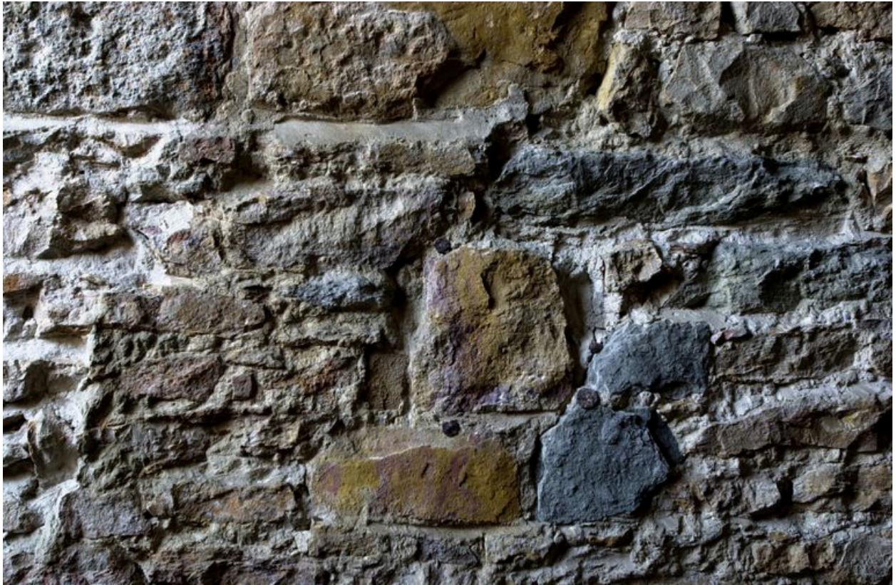
Détail des matériaux du mur ouest de la cage d'escalier
