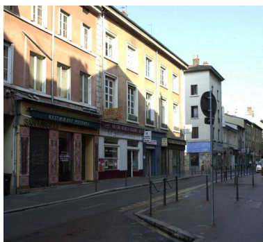
Elévation grande rue de la Guillotière Phot. Maryannick Chalabi IVR82_20096901132NUCA
