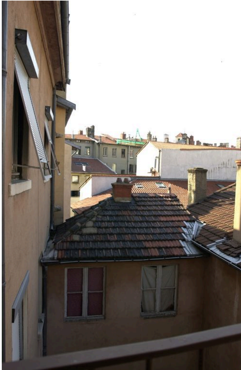
Corps de bâtiment en reour à l'est de la cour
