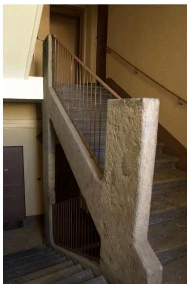
L'escalier du 2e étage Phot. Maryannick Chalabi IVR82_20096901144NUCA
