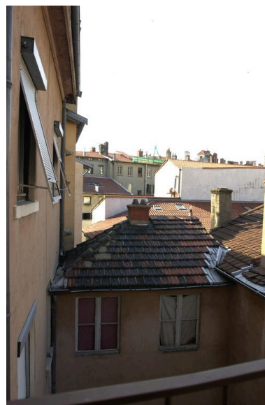
Corps de bâtiment en reour à l'est de la cour Phot. Maryannick Chalabi IVR82_20096901137NUCA
