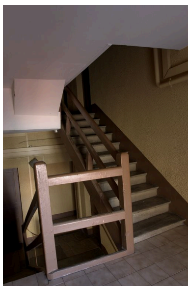
La dernière volée de l'escalier Phot. Maryannick Chalabi IVR82_20096901147NUCA
