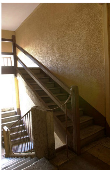
L'escalier du 3e étage, en bois, et à l'arrière le degré vers le balcon sur cour Phot. Maryannick Chalabi IVR82_20096901145NUCA
