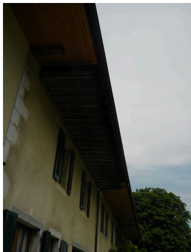
Vue du séchoir à noix sous le débord de toit en façade sud. Phot. Jérôme Daviet IVR82_20127400520NUCA
