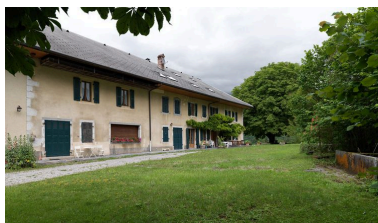
Vue de la cour avec la façade principale et le bassin privé lui faisant face. Phot. Eric Dessert IVR82_20117400144NUCA
