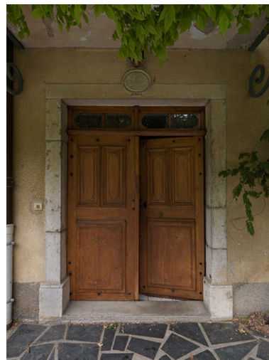
Vue de la porte d'entrée du logis de maître en façade sud. Phot. Eric Dessert IVR82_20117400146NUCA
