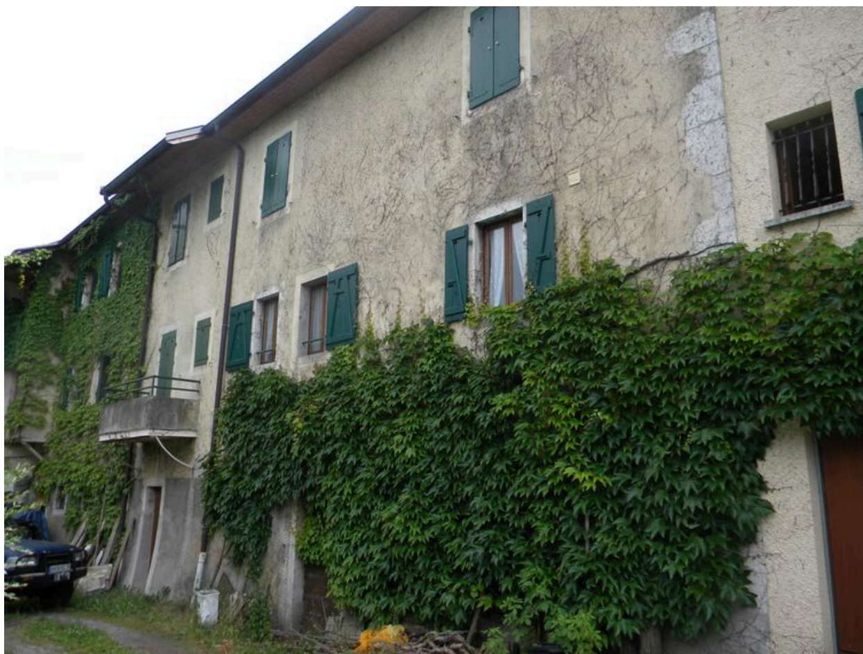
Vue de la façade arrière depuis l'ouest.
