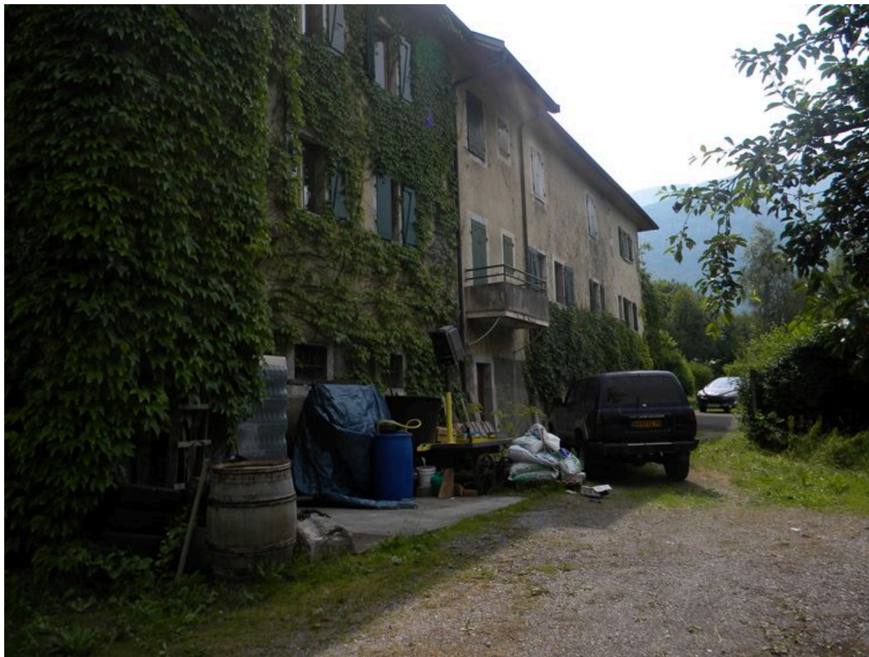
Vue de la face nord avec l'entrée de cave.
