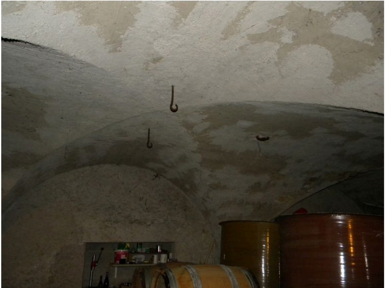
Détail des arêtes dans la cave à vin.
