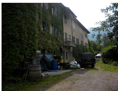
Vue de la face nord avec l'entrée de cave. Phot. Jérôme Daviet IVR82_20127400518NUCA
