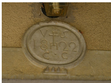
Vue du cartouche gravé sur le linteau. Phot. Jérôme Daviet IVR82_20127400522NUCA
