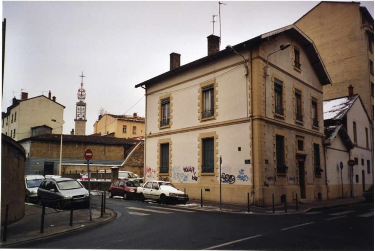
Vue d'ensemble est
