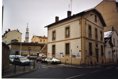
Vue d'ensemble est Phot. Nadine Halitim-Dubois IVR82_20066900167NUCA
