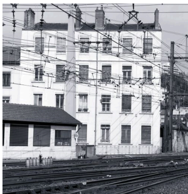
Elévation depuis la voie ferrée Phot. Eric Dessert IVR82_20026903566X
