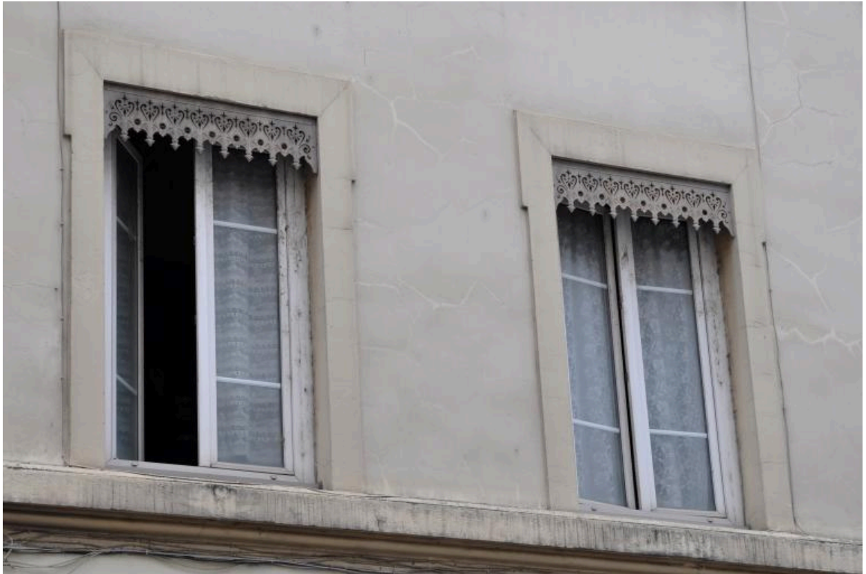
Elévaton sur rue, encadrements de baies à crossettes
