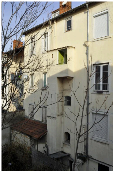
Elévation sur cour, vue d'ensemble Phot. Magali Delavenne IVR84_20186901067NUCA
