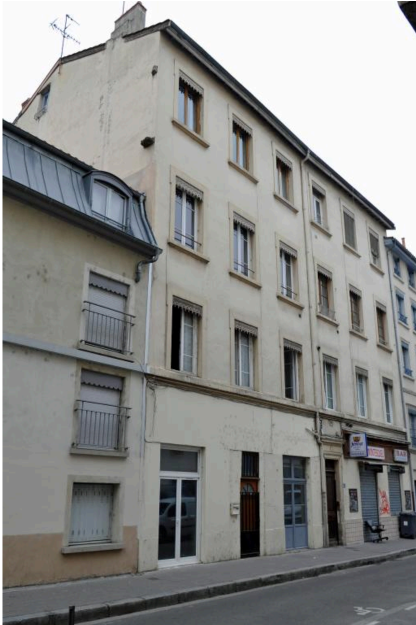
Elévation sur rue, vue d'ensemble
