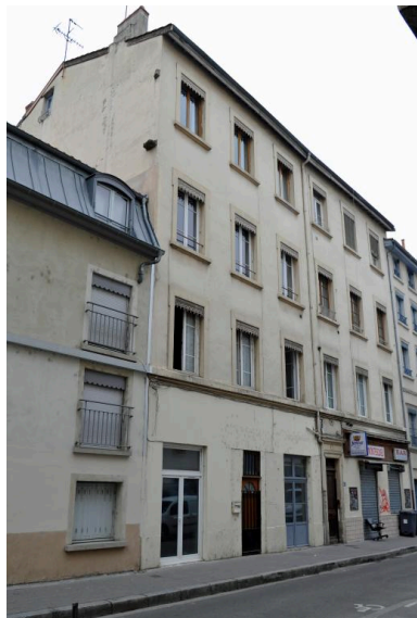
Elévation sur rue, vue d'ensemble Phot. Magali Delavenne IVR84_20186901066NUCA
