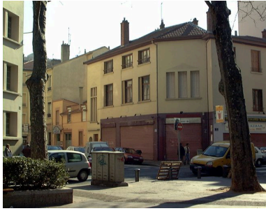
Façade sur rue, vue générale Phot. Bernard Ducouret IVR82_20016900854NUCA
