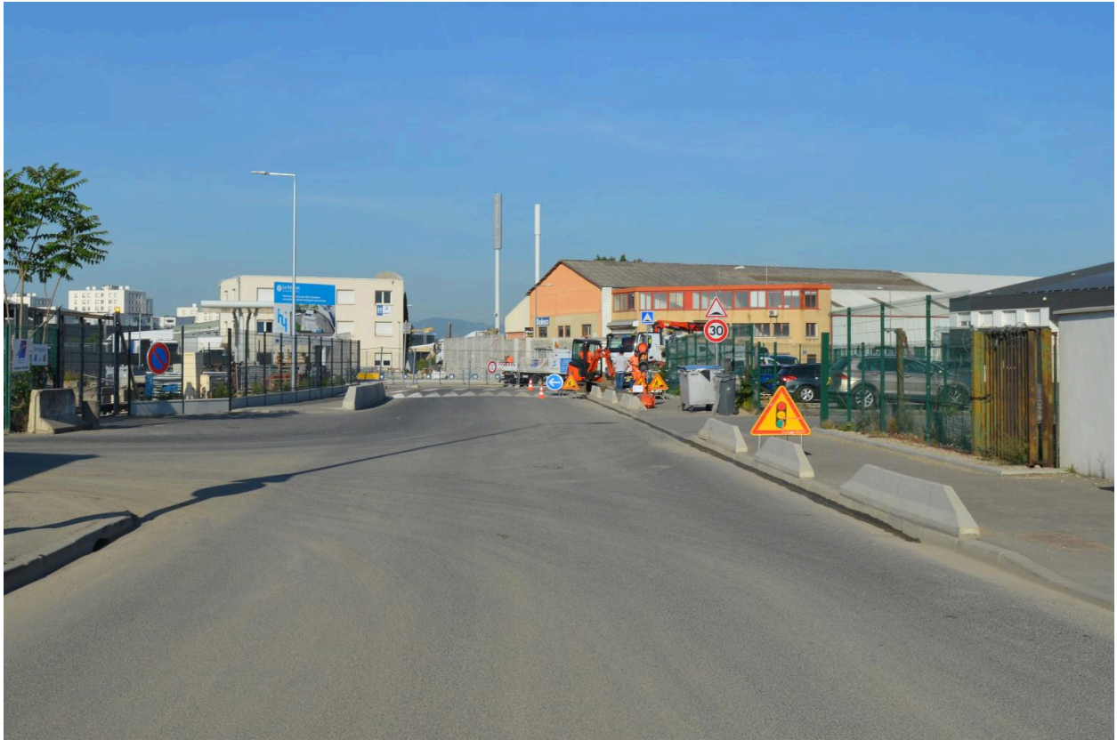
Industries actuelles situées sur le site de l'ancienne usine S.O.M.U.A. - Rolesco et Hitch'net - vues depuis le Chemin de Tâche Velin - mai 2022
