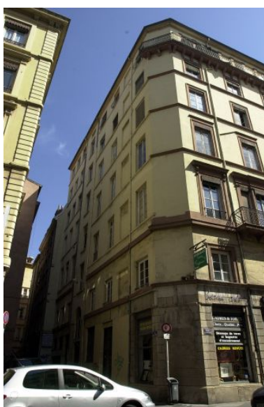
Façade sur la rue Valfenière Phot. Bernard Ducouret IVR82_20036901239NUCA
