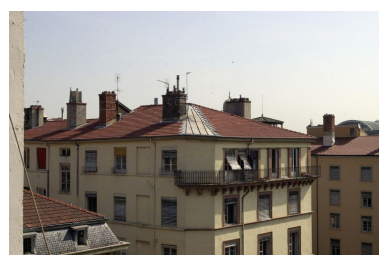
Façades sur les rues de la Platière et Valfenière, derniers étages Phot. Bernard Ducouret IVR82_20036901440NUCA
