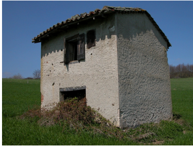
Vue générale. Phot. Thierry Monnet IVR82_20114201879NUCA
