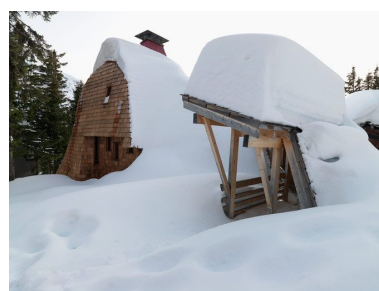
Entrées des chalets Sud et Tatou Phot. Eric Dessert IVR82_20107401183NUCA
