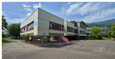
Vue générale depuis l'entrée Phot. Franck Trabouillet IVR84_20243800190NUCA
