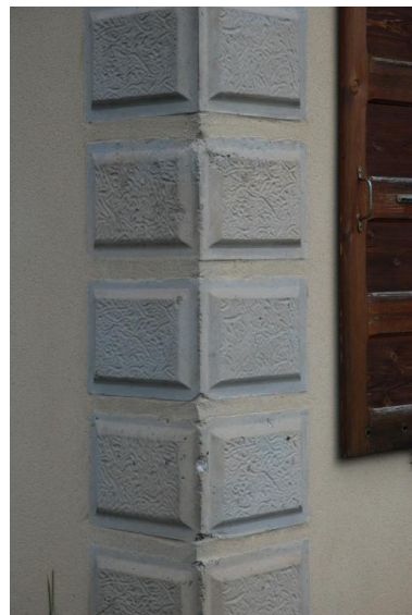
Angle en béton moulé à décor de bossage. Maison (2017 C4 288), non repérée. Phot. Caroline Guibaud IVR84_20207400784NUCA
