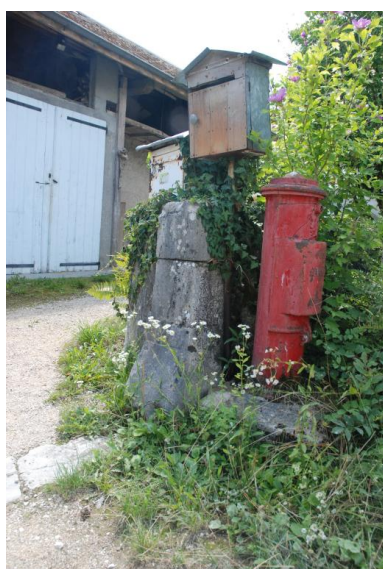
Ferme (2017 C4 331), non repérée. Chasse-roue à l'entrée de la cour. Phot. Caroline Guibaud IVR84_20207402510NUCA
