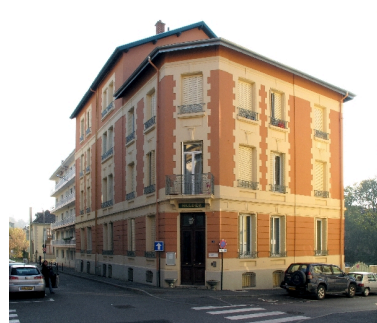
Vue d'ensemble Phot. François Fouger IVR82_20127300247NUCA
