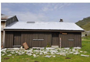
Vue de la façade antérieure sud Phot. Samir Mahfoudi
