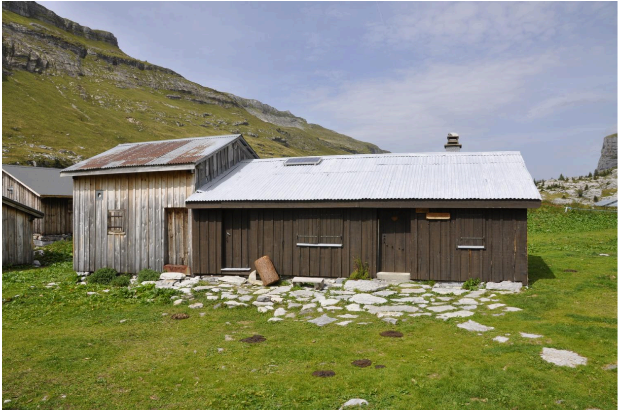
Vue d'ensemble des deux chalets contigus
