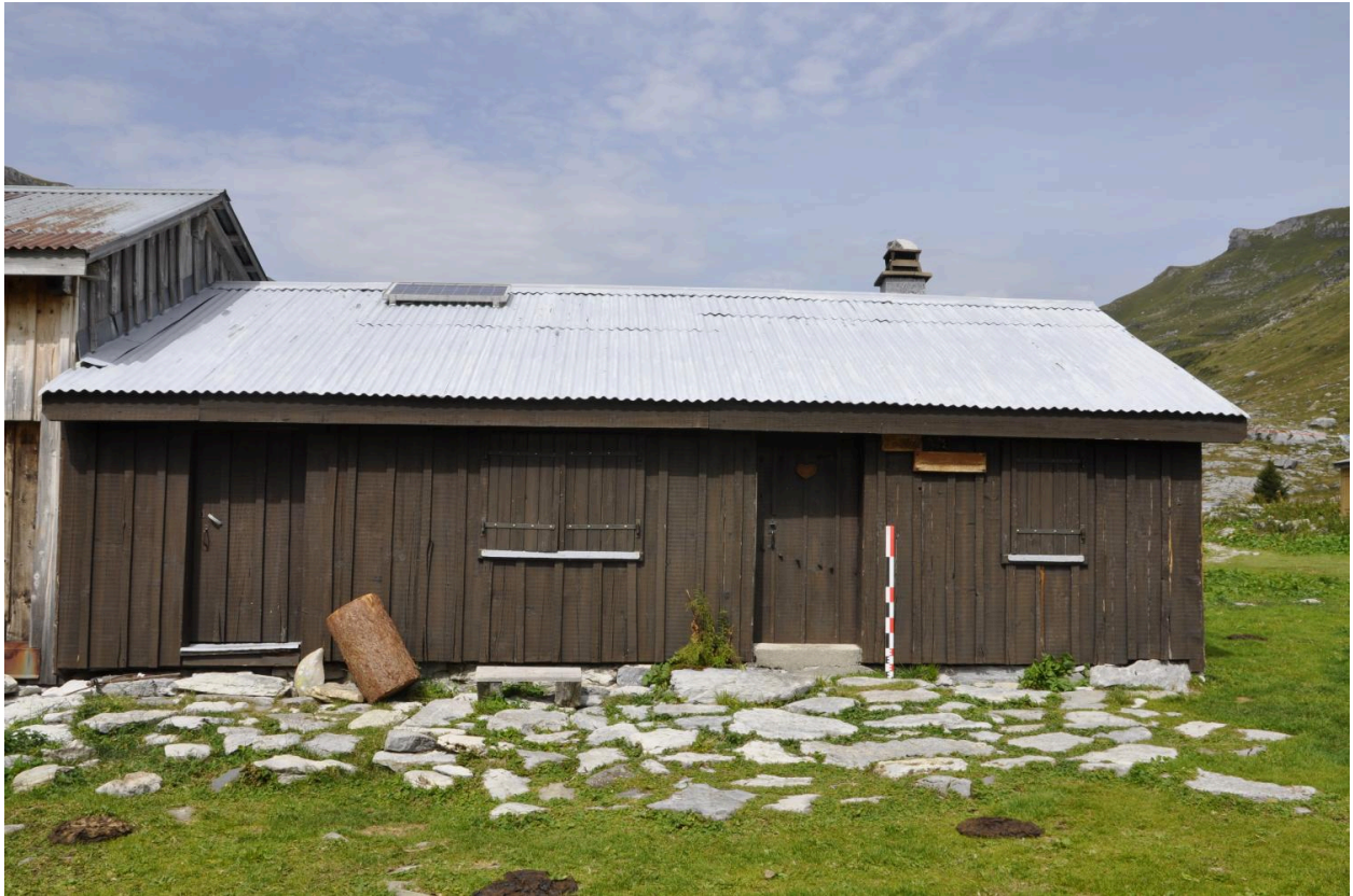
Vue de la façade antérieure sud
