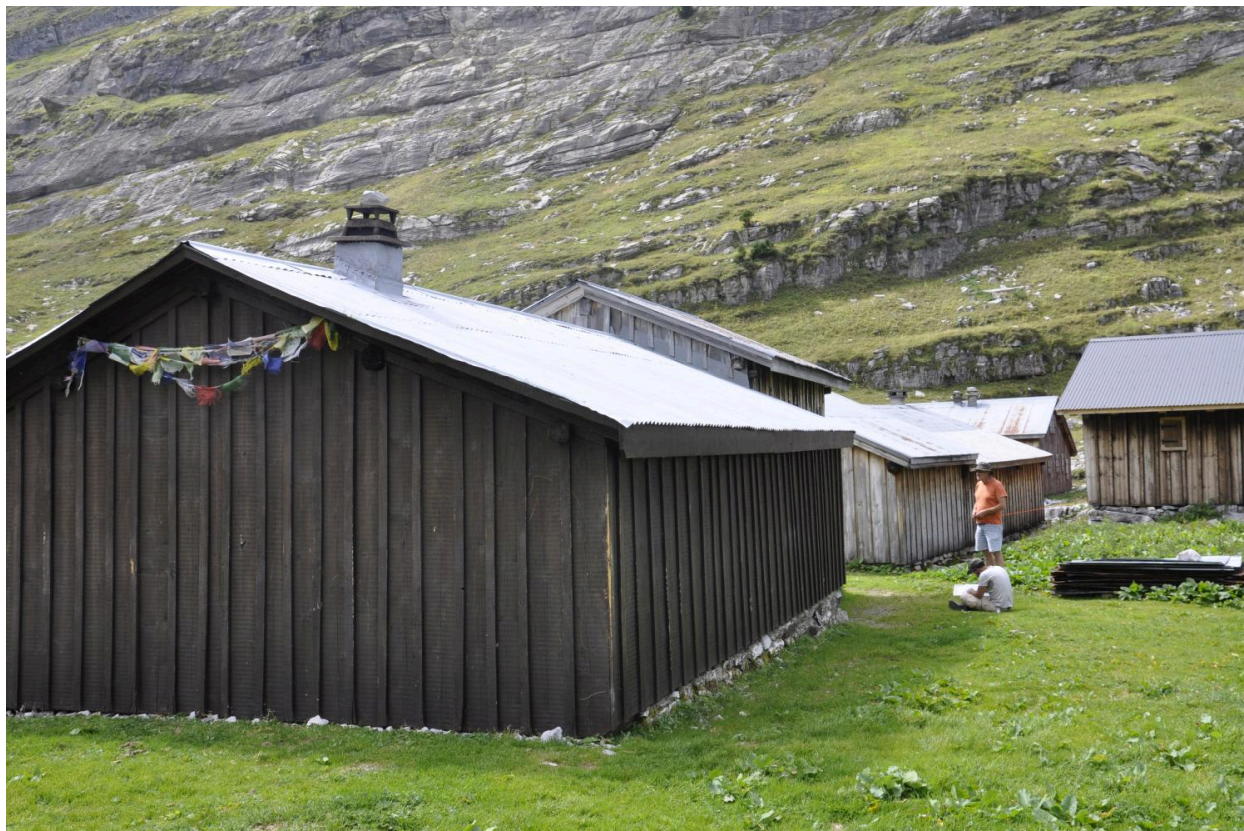
Vue de l'élévation nord-est
