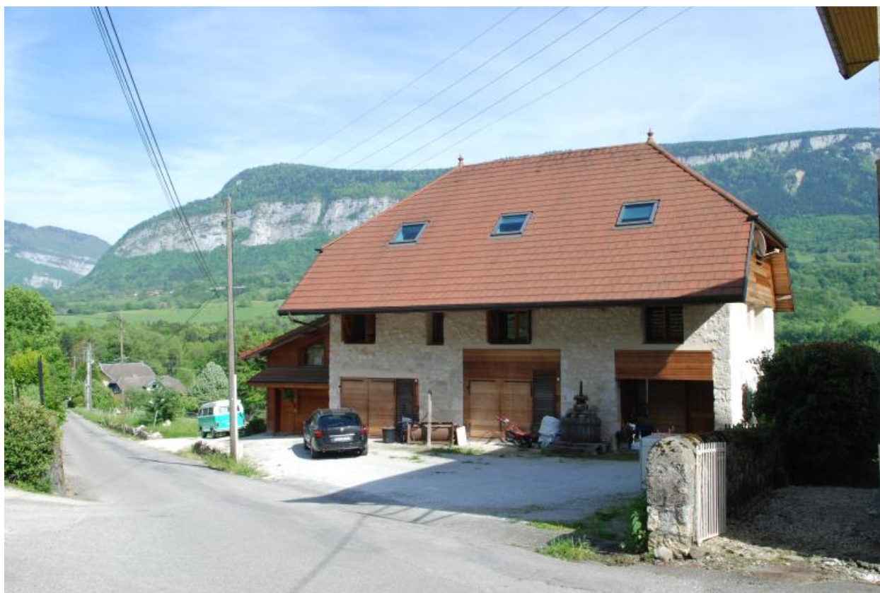
Vue d'ensemble de la grange-étable, ancienne dépendance.
