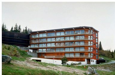
Elévation principale, au sud Phot. Jean-François Lyon-Caen IVR82_19987300030ZA
