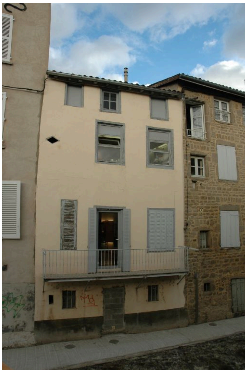
Elévation postérieure donnant sur le quai du Vizézy.
