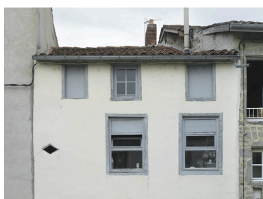
Vue partielle de l'élévation postérieure : encadrements de baies en bois. Phot. Didier Gourbin IVR82_20074201277NUCA
