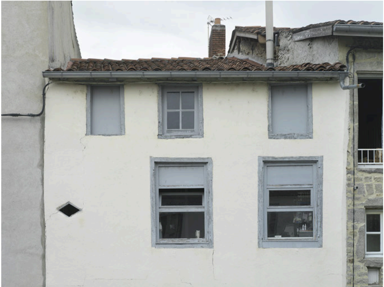
Vue partielle de l'élévation postérieure : encadrements de baies en bois.
