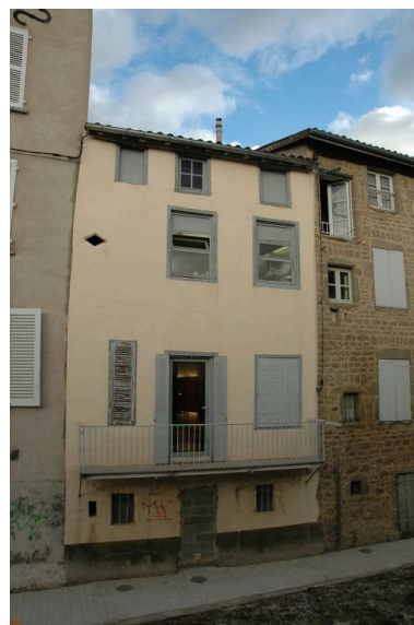
Elévation postérieure donnant sur le quai du Vizézy. Phot. Simone Hartmann-Nussbaum IVR82_20134200535NUCA
