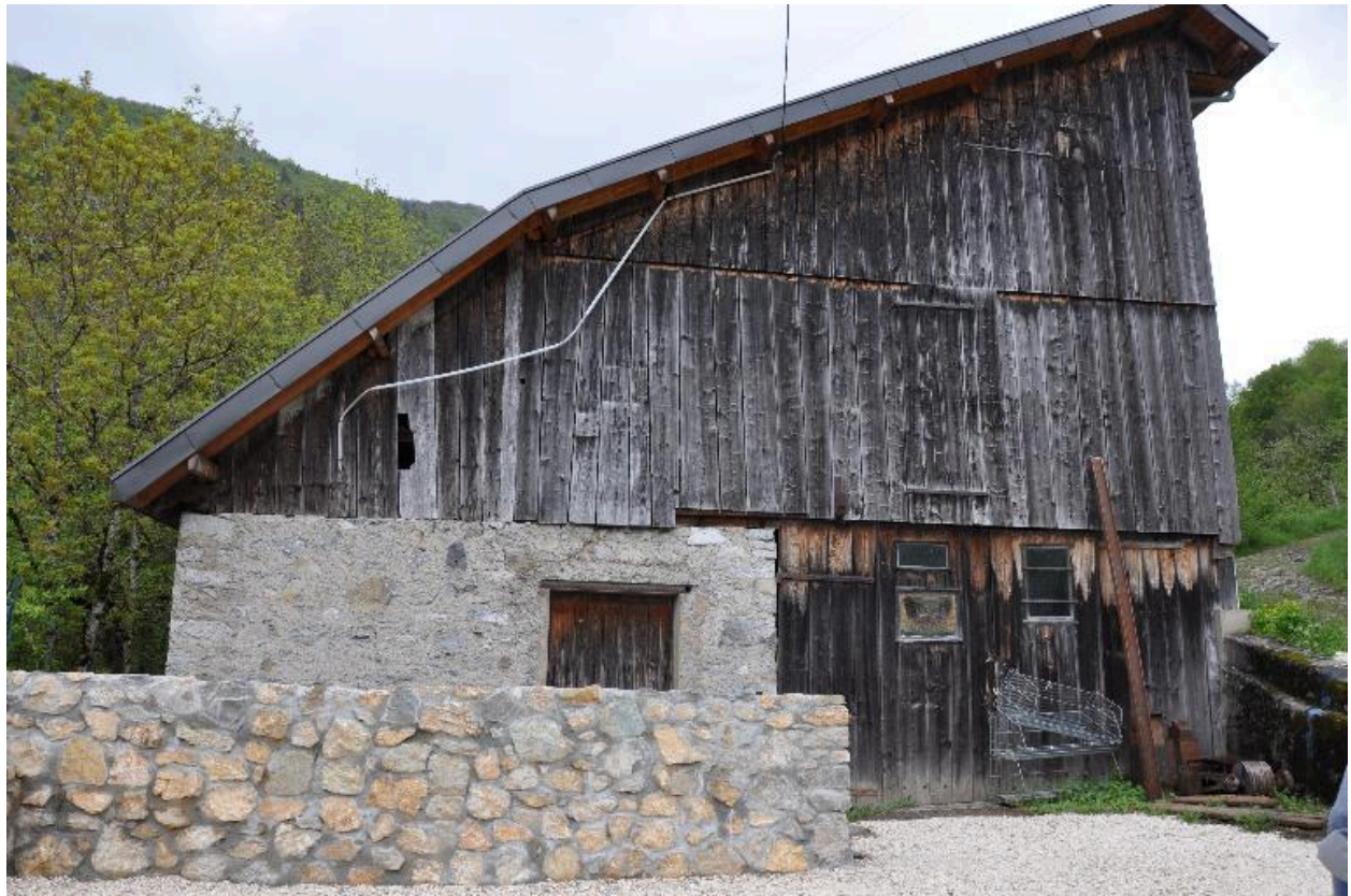
Vue de la façade sud de l'atelier.
