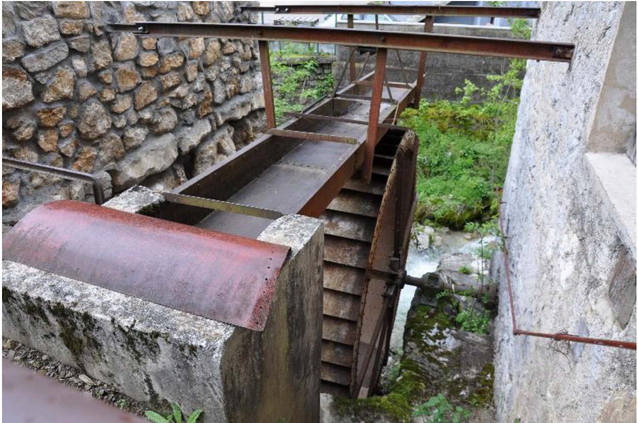
Canal d'arrivée de l'eau au dessus de la roue.
