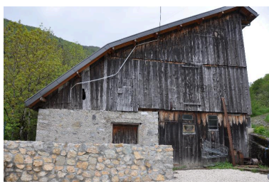
Vue de la façade sud de l'atelier. Phot. Clara Bérelle IVR82_20137301652NUCA
