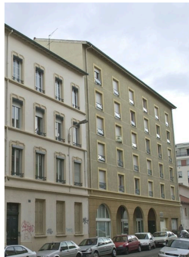
Vue de la façade sur rue depuis le sud-ouest Phot. Maryannick Chalabi IVR82_20066901288NUCA
