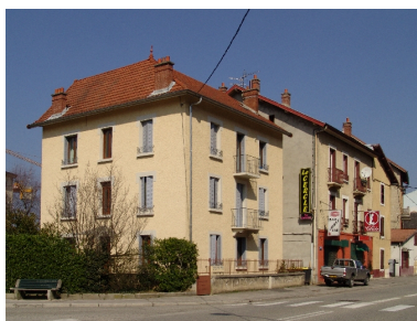
Vue dans la rue Phot. François Fouger IVR82_20097300551NUCA
