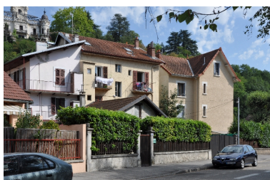
Vue d'ensemble: bâtiment à gauche Phot. François Fouger IVR82_20127301091NUCA
