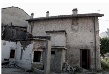
Maison, façade postérieure et vestiges de dépendances Phot. Denys Harreau IVR82_20147301028NUCA
