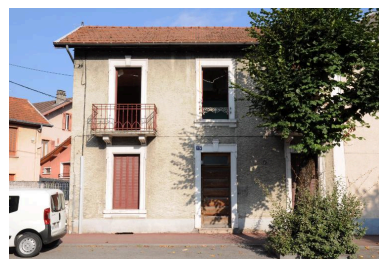
Maison, élévation sur l'avenue Saint-Simond Phot. Denys Harreau IVR82_20147301026NUCA
