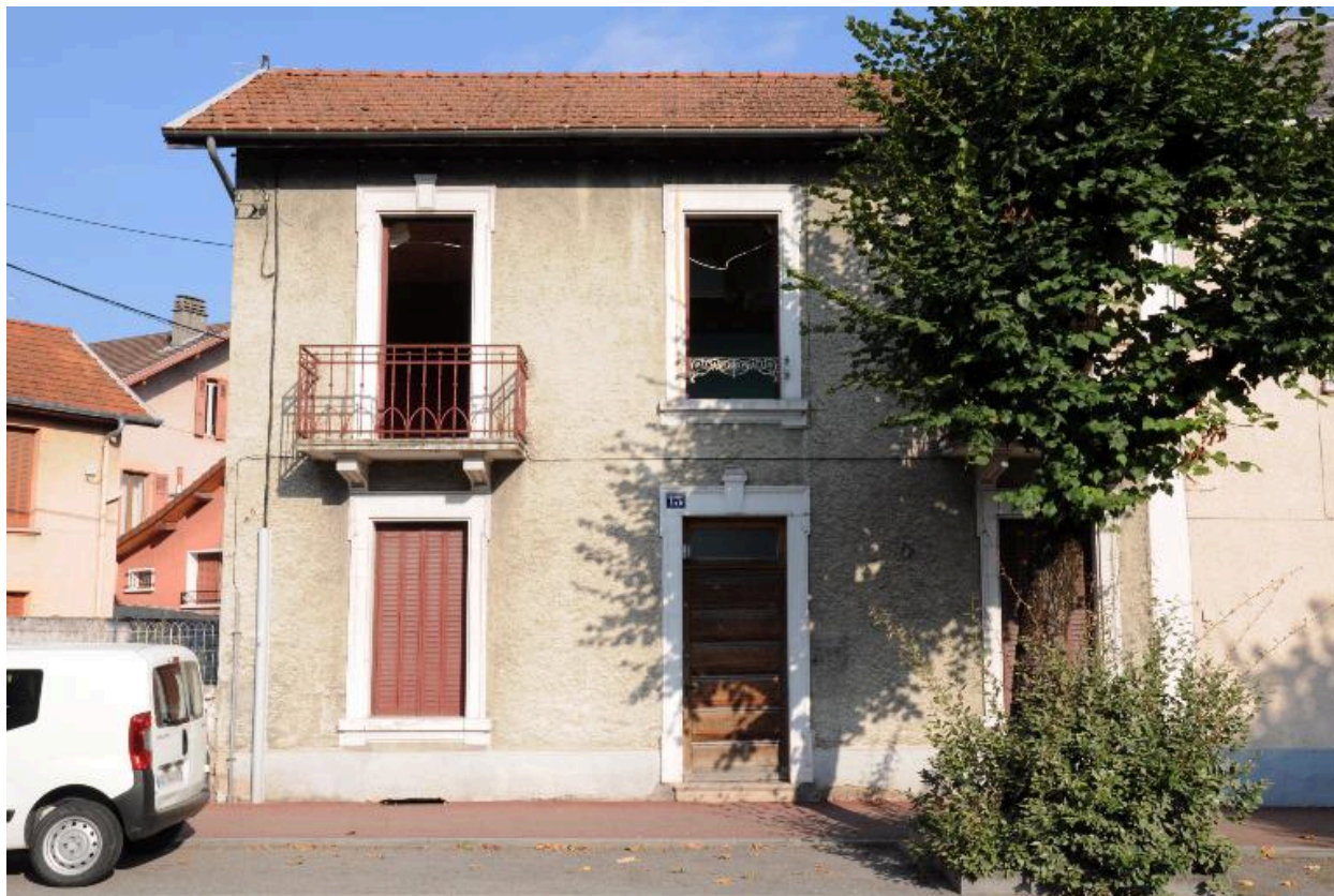
Maison, élévation sur l'avenue Saint-Simond
