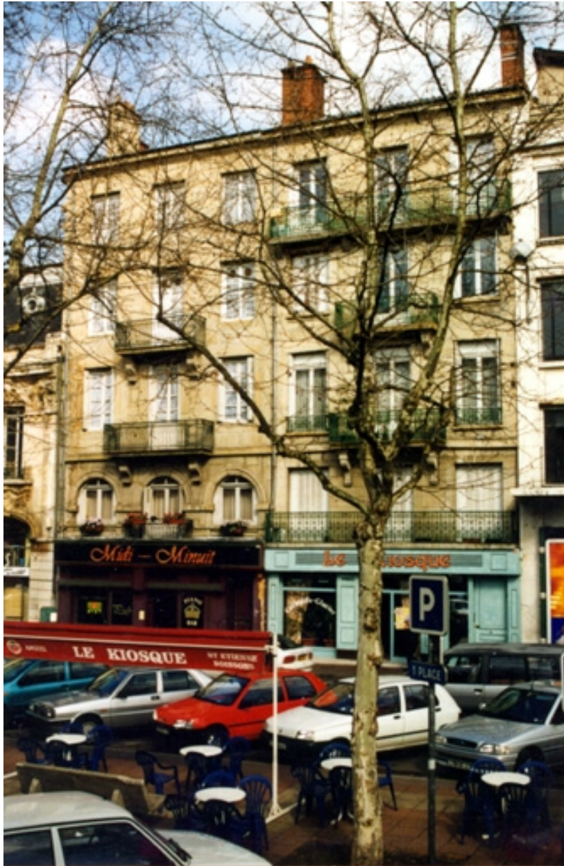
Façade principale. Etat en 1996
