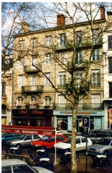
Façade principale. Etat en 1996 Phot. Cendrine Sanquer IVR82_19974202045ZE
