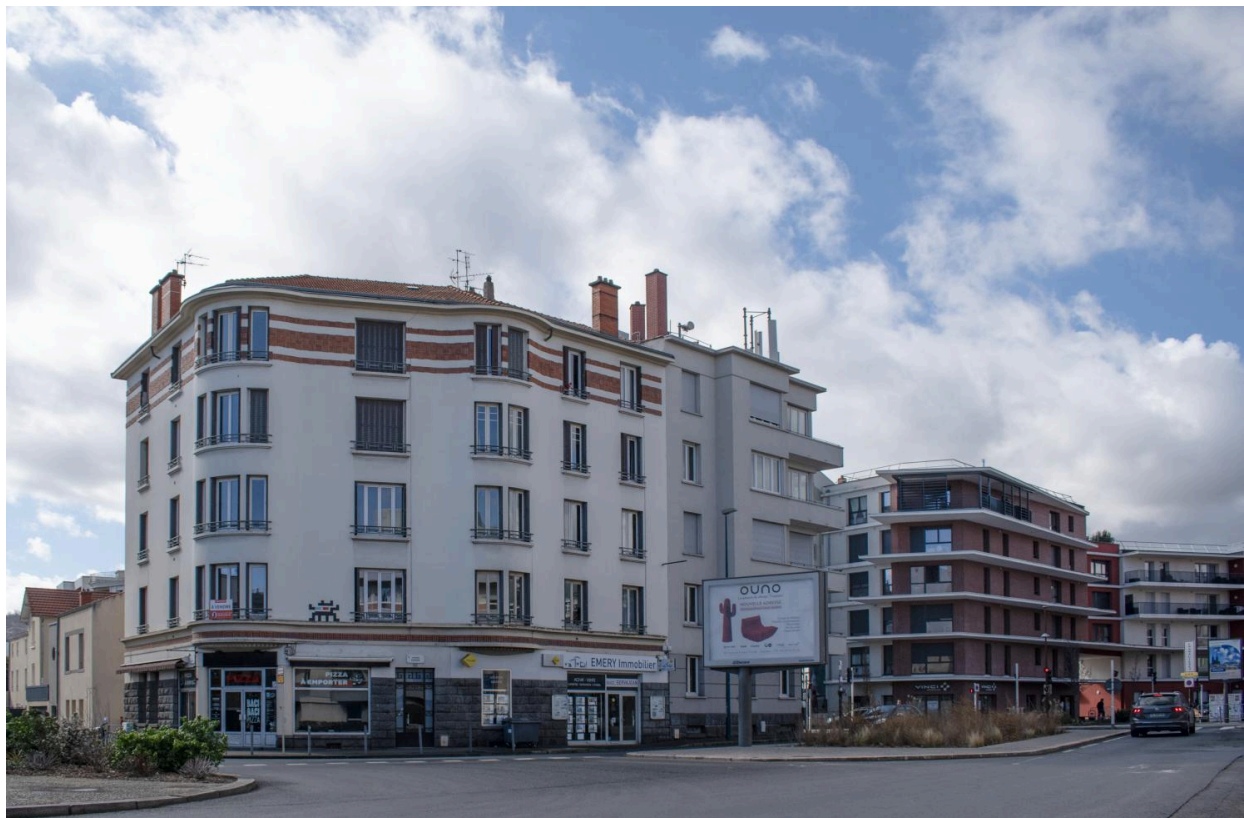
Façade sur le carrefour des boulevards Aristide-Briand et Duclaux, angle sur la rue Gourgouillon
