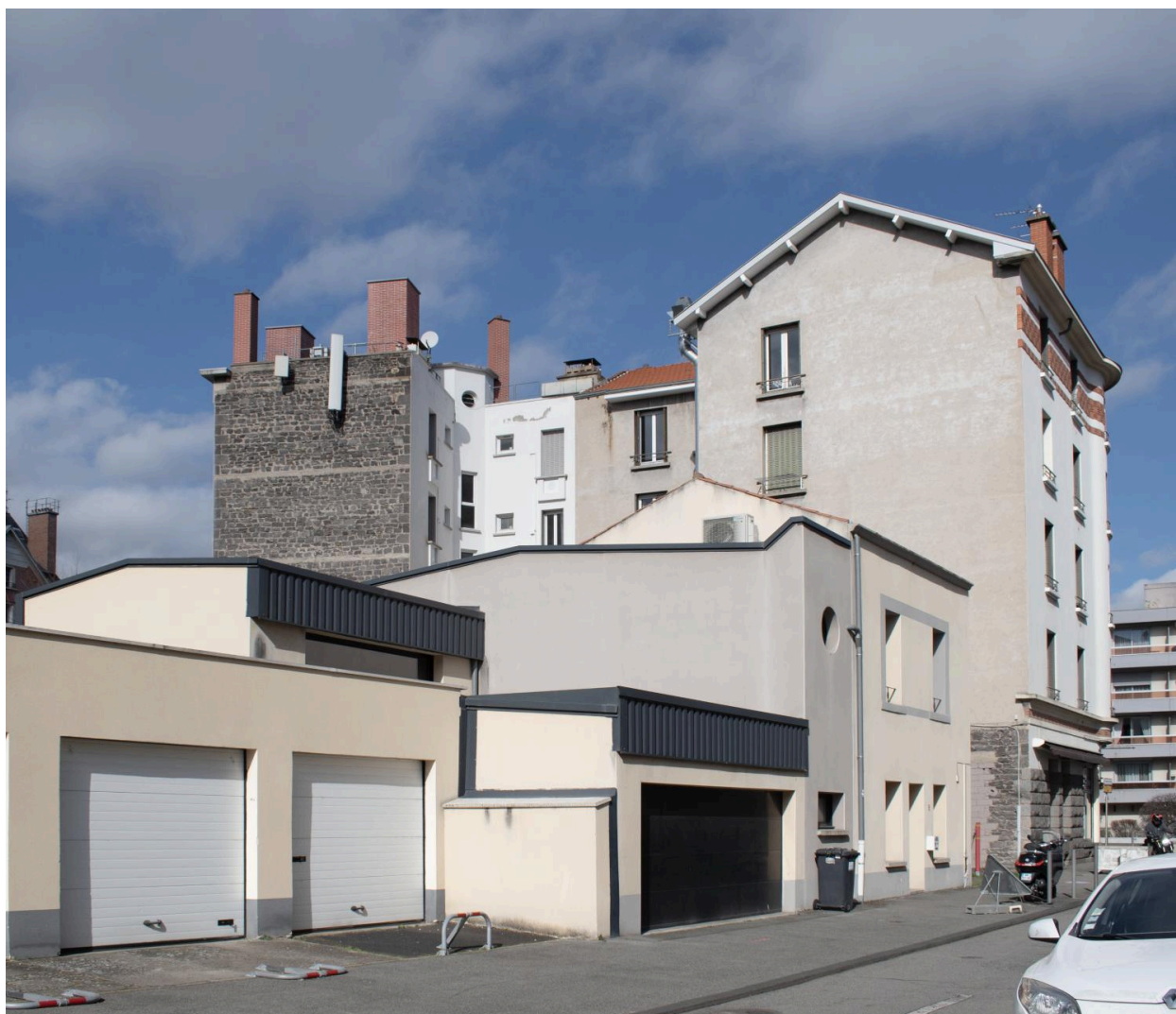
Élévations postérieures depuis la rue Gourgouillon
