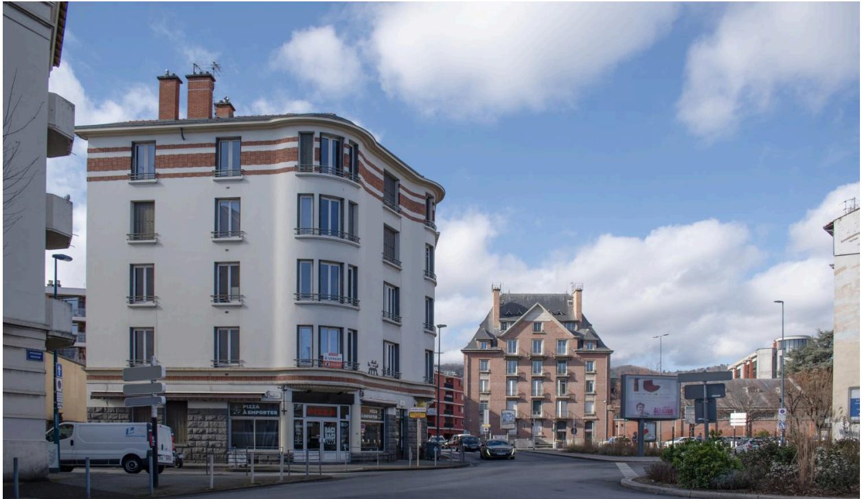
Elévation latérale sur la rue Gourguillon. A l'arrière-plan, bâtiment de l'imprimerie de la banque de France.
