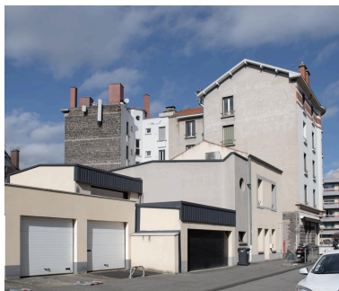
Élévations postérieures depuis la rue Gourguillon Phot. Félicie Fougère IVR84_20256302353NUCA
