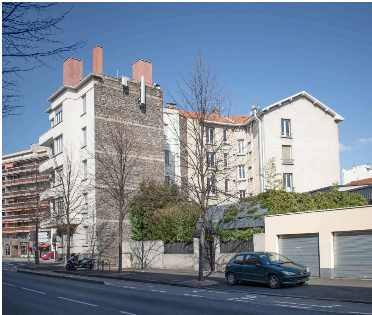
Elévation postérieure des immeubles n°50 et 46 avenue Pasteur. Vue depuis le boulevard Aristide-Briand
