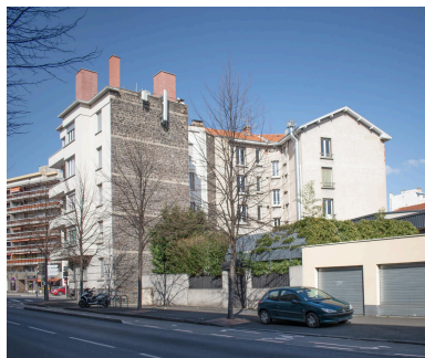
Élévation postérieure des immeubles n°50 et 46 avenue Pasteur. Vue depuis le boulevard Aristide-Briand Phot. Félicie Fougère IVR84_20256302300NUCA
