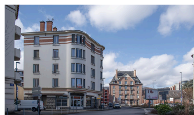
Elévation latérale sur la rue Gourgouillon. A l'arrière-plan, bâtiment de l'imprimerie de la banque de France. Phot. Félicie Fougère IVR84_20256302352NUCA
