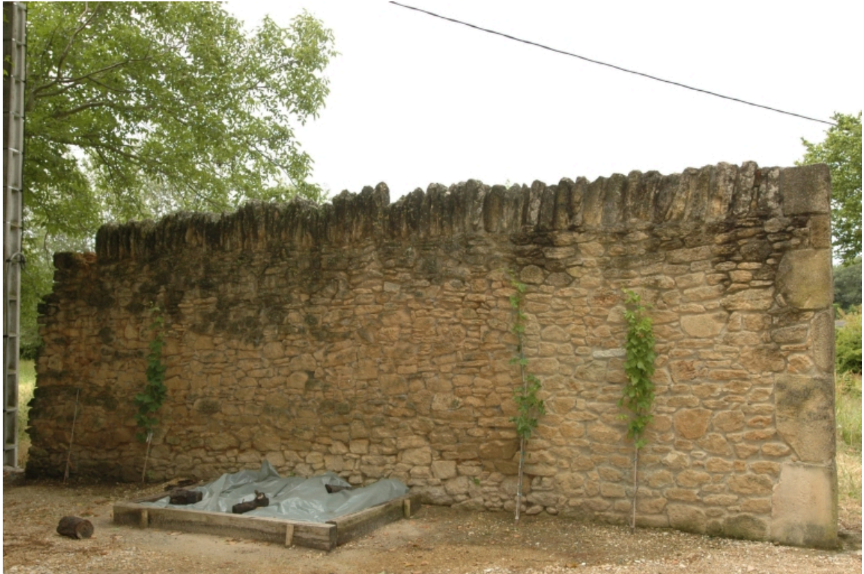
Les Fournaches, exemple de mise en oeuvre d'un mur de clôture.
