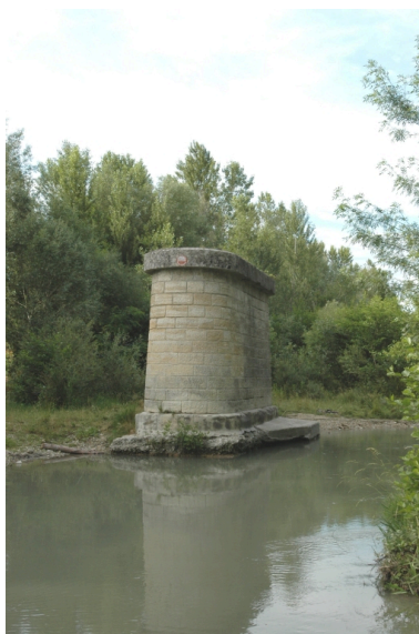
Rochebouteille, vestige d'une pile du pont de l'ancienne voie ferrée. Phot. S. Joly IVR82_20092600509NUCA
