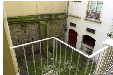
Vue de la cour en contrebas Phot. François Blanchetière IVR82_20016901949NUCA
