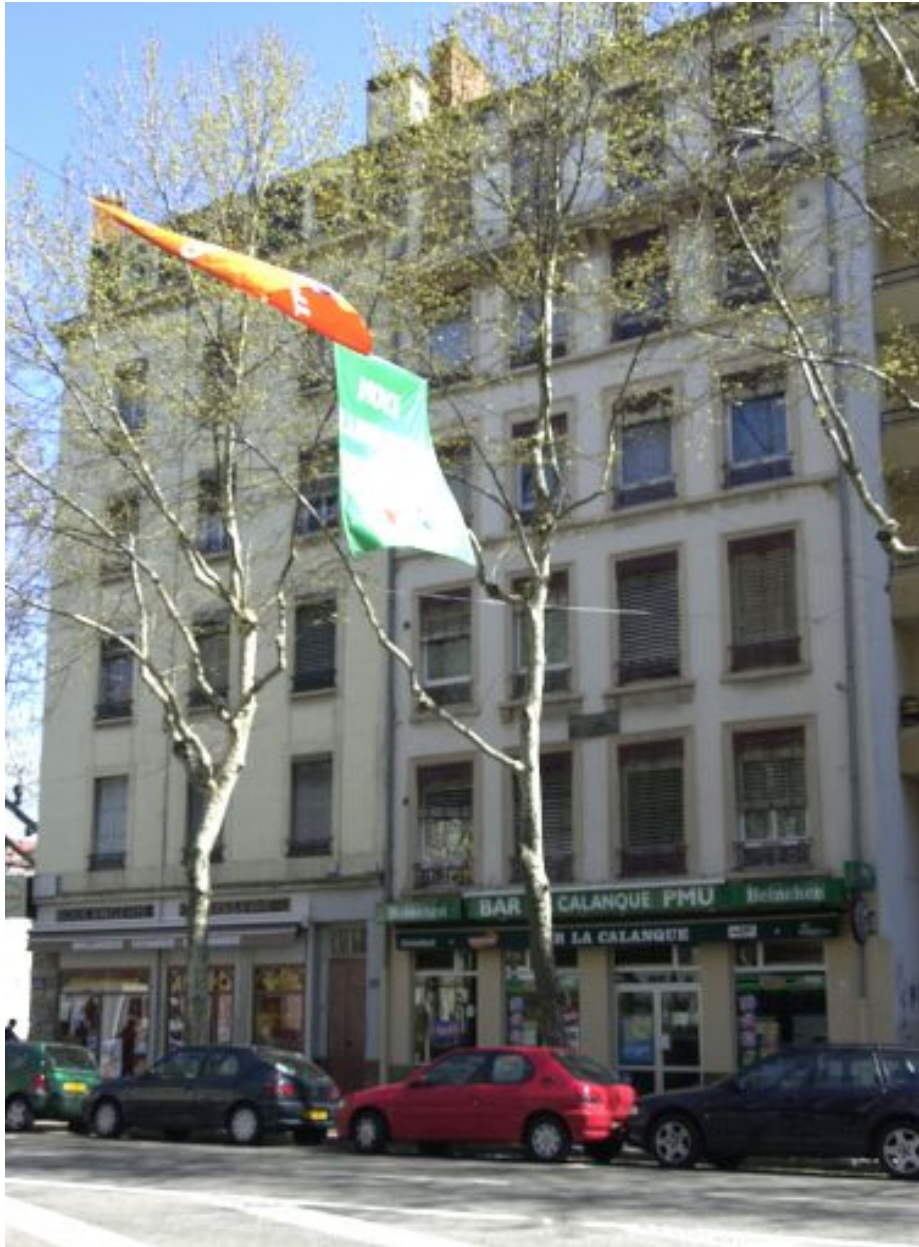
Vue d'ensemble des 71-69 cours Charlemagne depuis le sud-ouest
