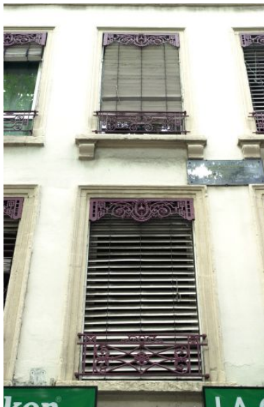
Détail des fenêtres Phot. François Blanchetière IVR82_20016901948NUCA
