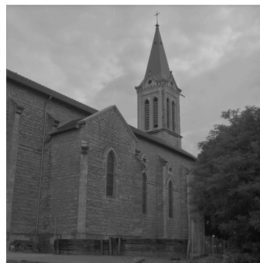
Vue d'ensemble depuis le nord-est. Phot. Eric Dessert, Phot. Jean-Marie Refflé IVR82_19920100643X
