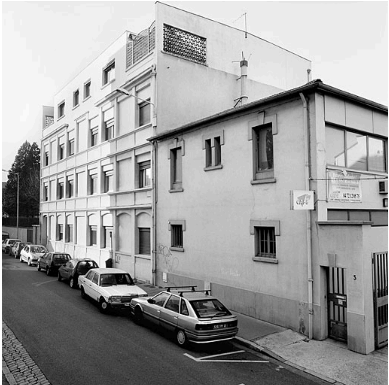
Vue générale est
