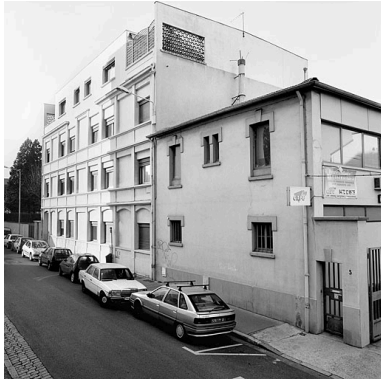
Vue générale est Phot. Didier Gourbin IVR82_20046902521X
