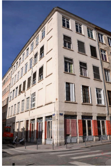
Façade est Phot. Noémie Caillat IVR82_20156900286NUCA
