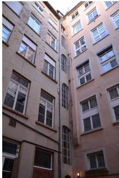
Façades sur cour Phot. Noémie Caillat IVR82_20156900294NUCA
