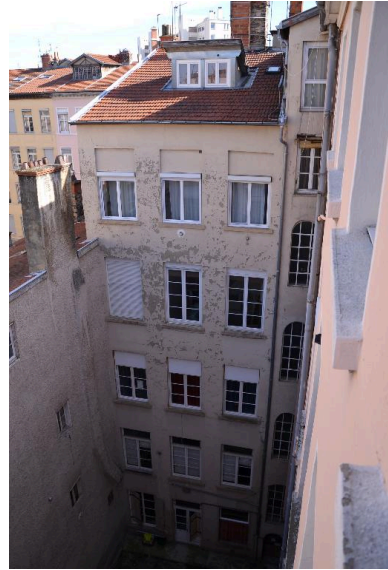
Façade sur cour Phot. Noémie Caillat IVR82_20156900281NUCA
