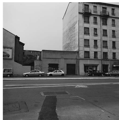
Vue nord Phot. Jean-Marie Refflé IVR82_20026905009X
