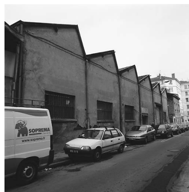
Vue est, rue Maurice Flandrin Phot. Jean-Marie Refflé IVR82_20026905012X
