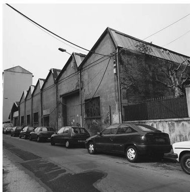
Façade est, vue d'ensemble des ateliers Phot. Jean-Marie Refflé IVR82_20026905013X
