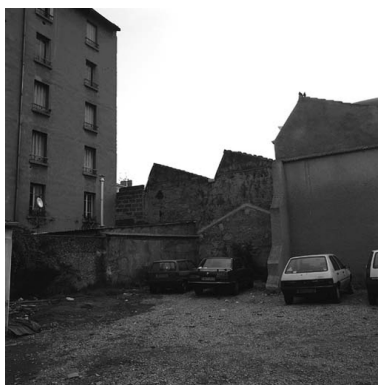
Vue ouest de la cour de l'immeuble Phot. Jean-Marie Refflé IVR82_20026905011X
