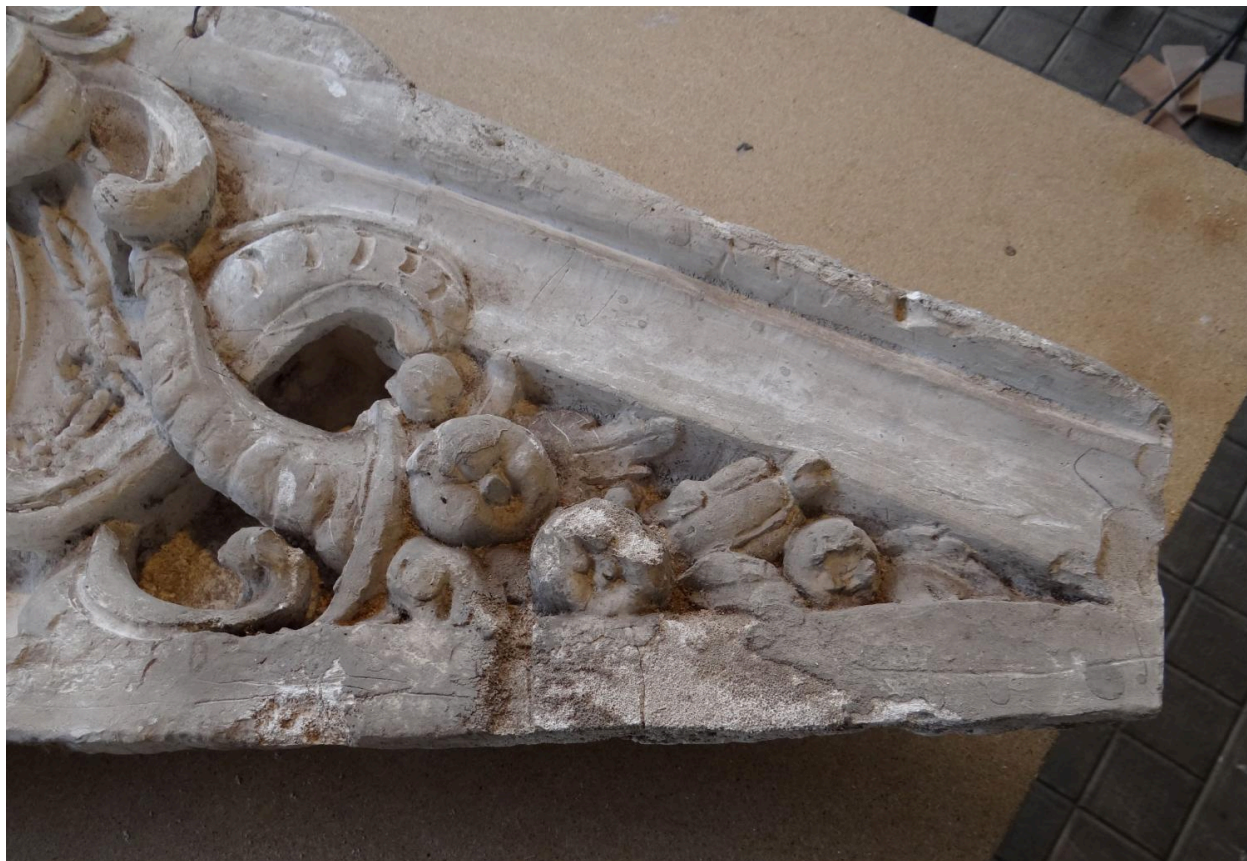
Vue générale de HC 178-13
